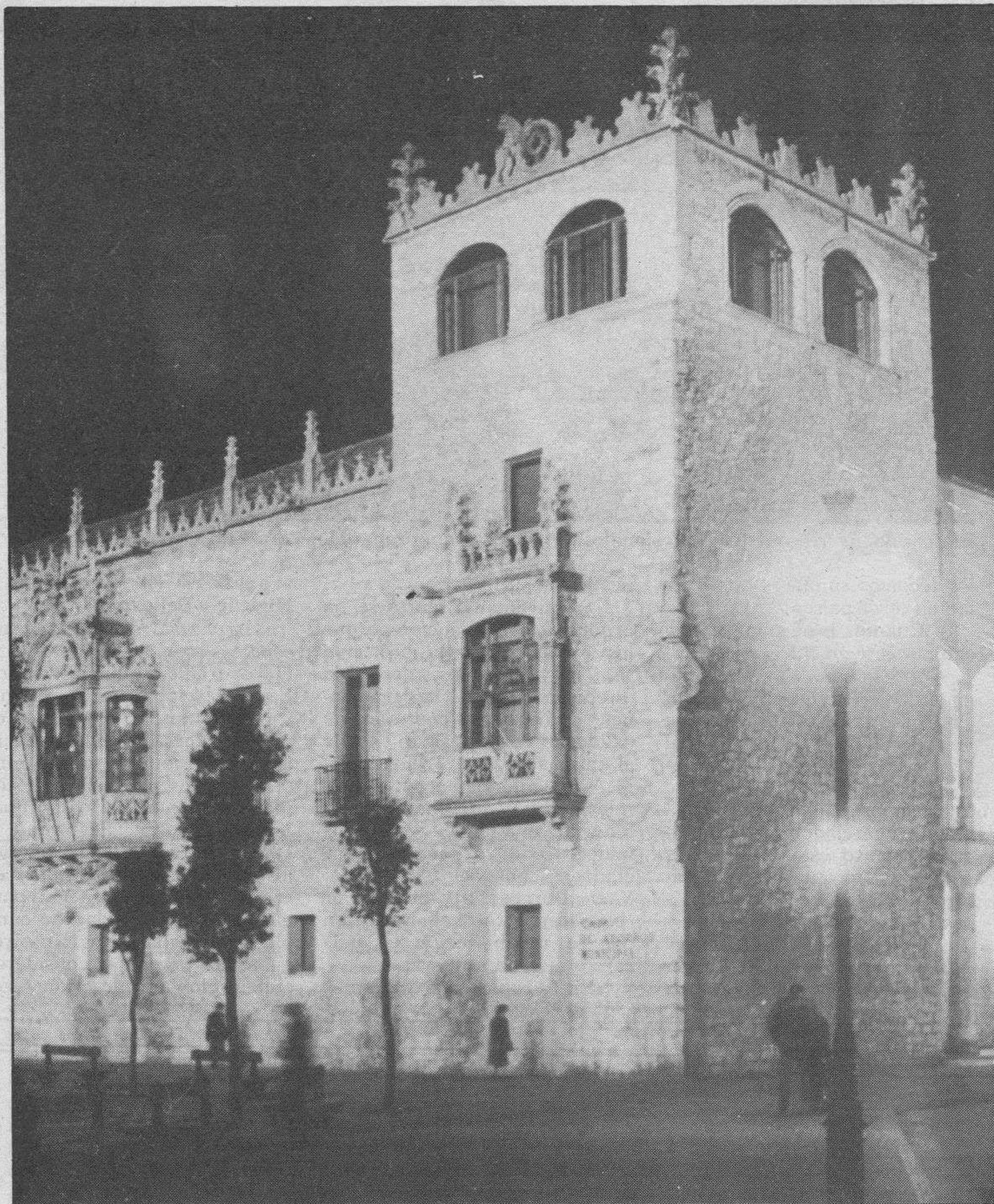
La aparejadores tienen competencias en la rehabilitación de edificios.
