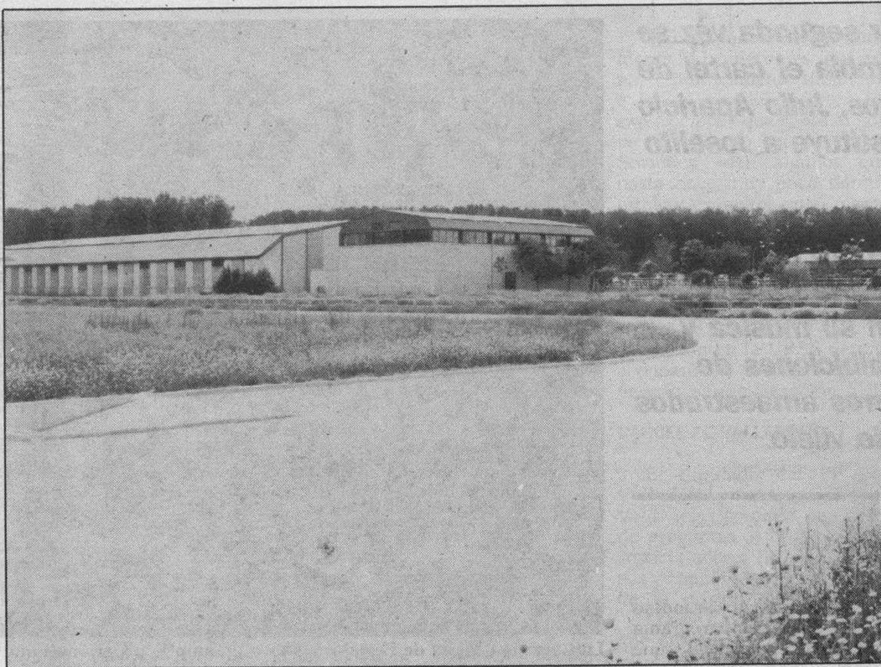
Aunque las obras siguen paralizadas se espera su inmediata terminación. (Foto: Truchuelo)
