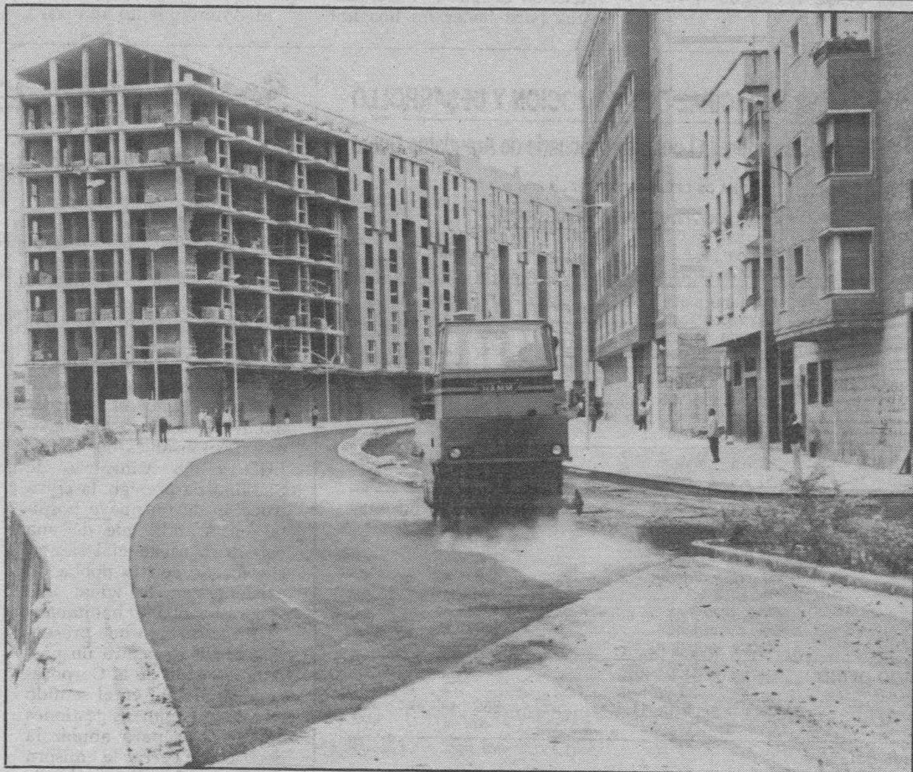
ASFALTADO DEL ÚLTIMO TRAMO DE LA RONDA DEL FERROCARRIL.-La semana pasada hablábamos de una serie de obras urbanísticas que quedarían finalizadas en breves fechas. Entre ellas mencionábamos la terminación del asfaltado del último tramo de la Ronda del Ferrocarril que incluye la calle Doctor Fleming y que se ha estado realizando en los últimos días, de forma que ya está definitivamente abierta al paso de vehículos y de peatones. (Foto: Truchuelo).
