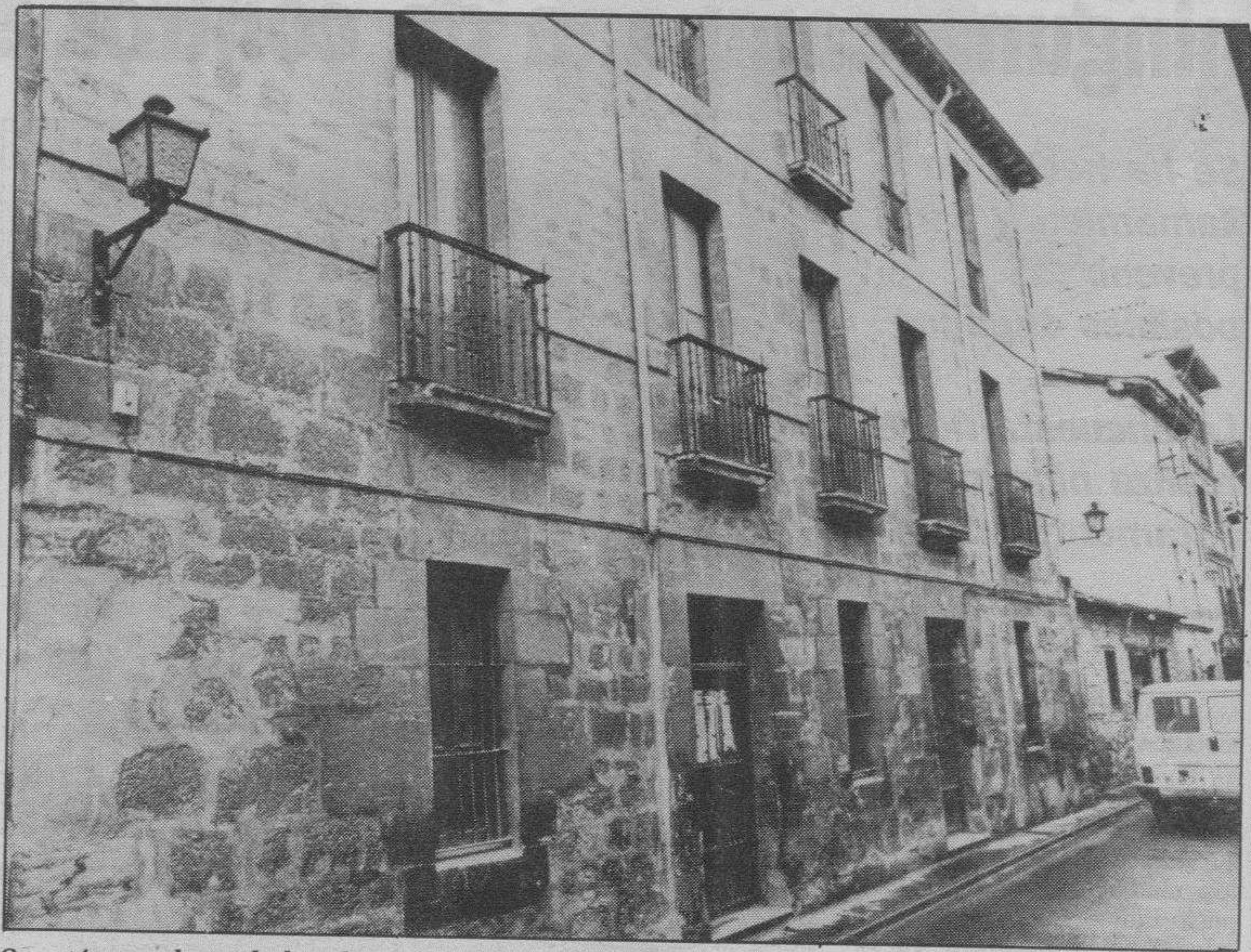
Se están concluyendo las obras del edificio. (Foto: Truchuelo).
