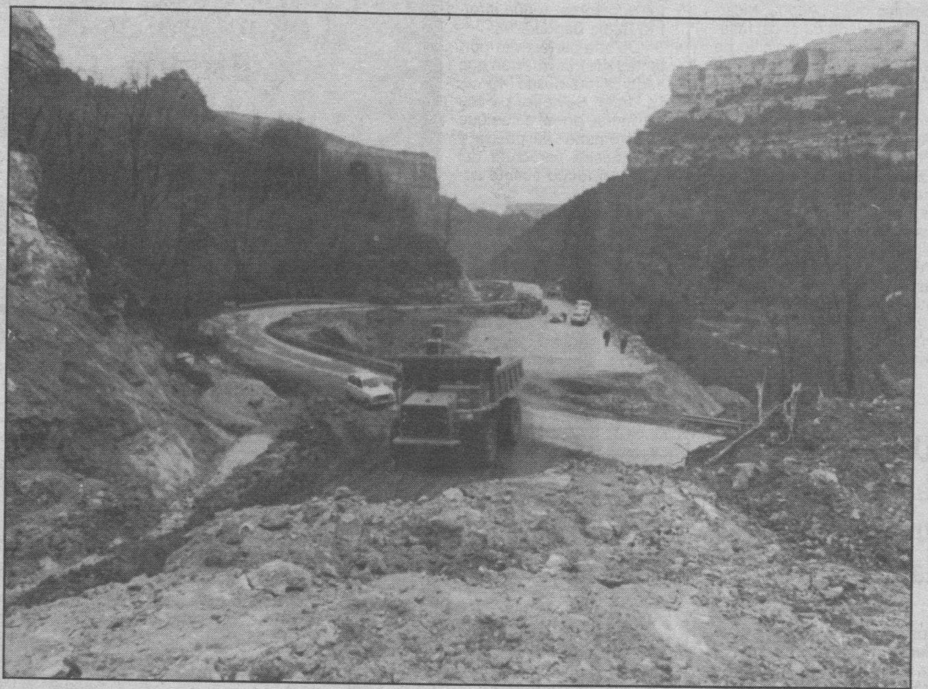
Supresión de curvas. — Las obras de la carretera de Santander desde Burgos avanzan. Hay mucho que hacer, pero suprimir una sola curva en un trazado como ese ya es importante. Eso es lo que se está haciendo entre Valdelateja y Quintanilla Escalada.
