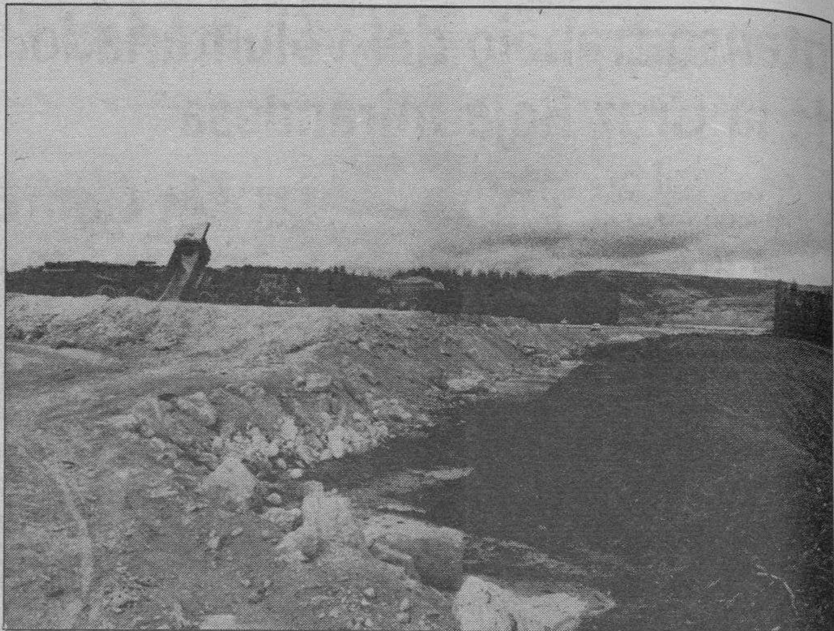
Las obras de la autovía en el tramo de Aranda continúan sin tener en cuenta los accesos que piden algunos pueblos. Foto Lara.
