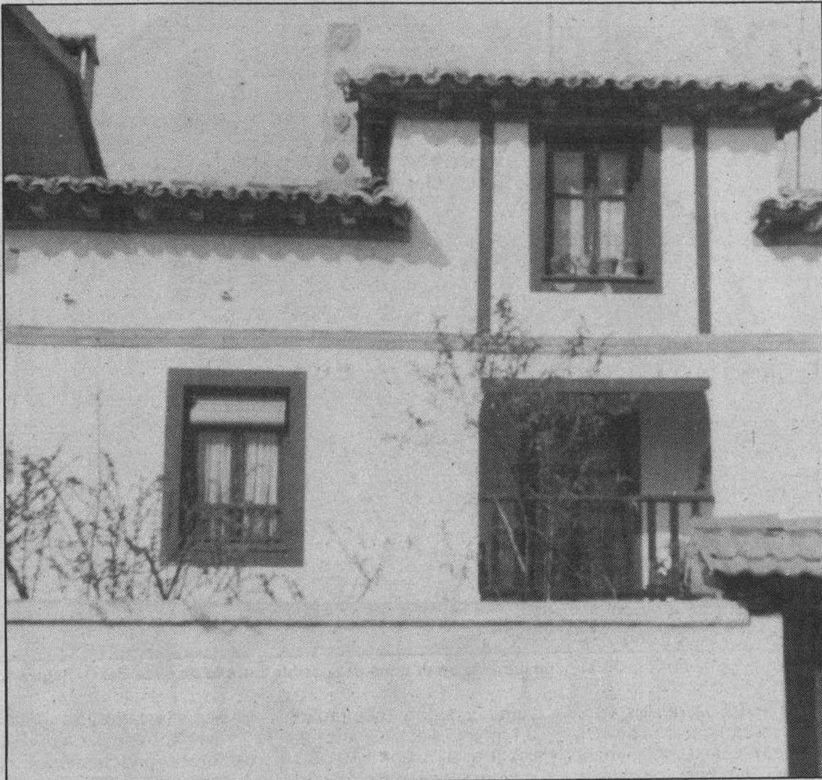
Vivienda rural remozada. En la parte superior izquierda se ven dos puntos negros, son dos orificios por donde salen y entran las abejas en la colmena, dujo o tojo.
