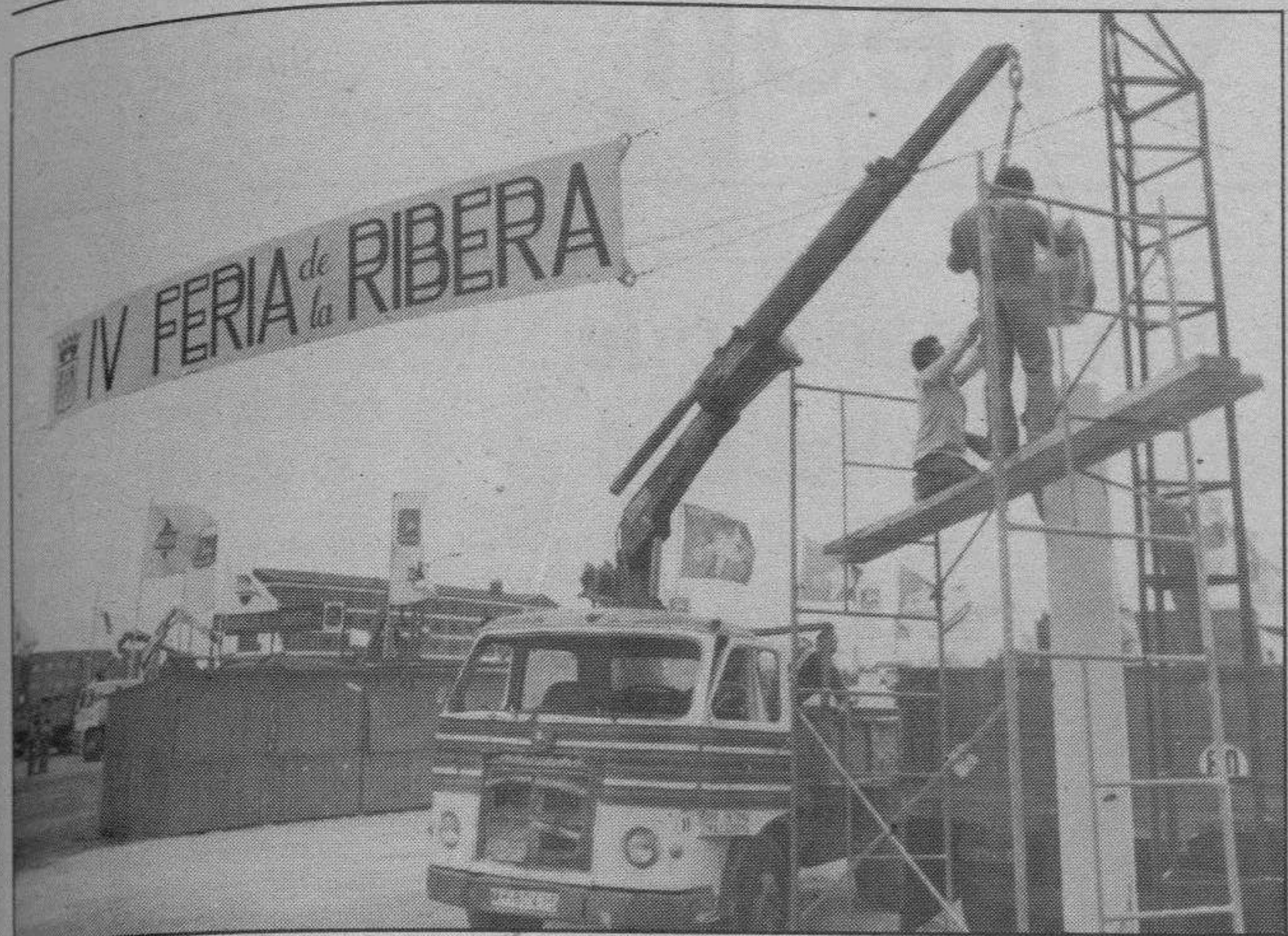
Los técnicos municipales estuvieron hasta ayer mismo dando los últimos toques a la infraestructura del recinto. Foto Lara.
