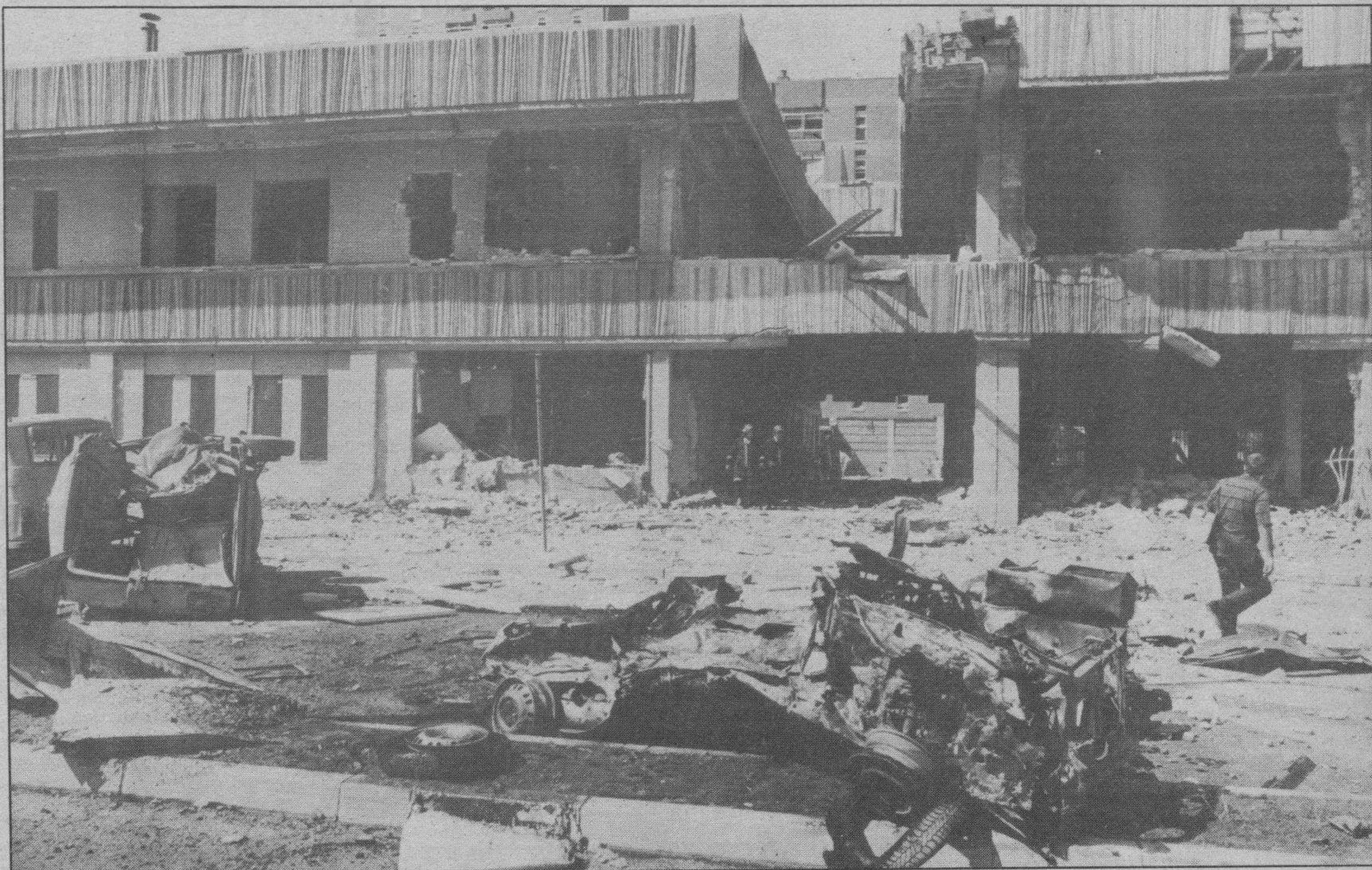
Tras uno de los coches afectados se ve el estado en que quedó el edificio de Comisaría
