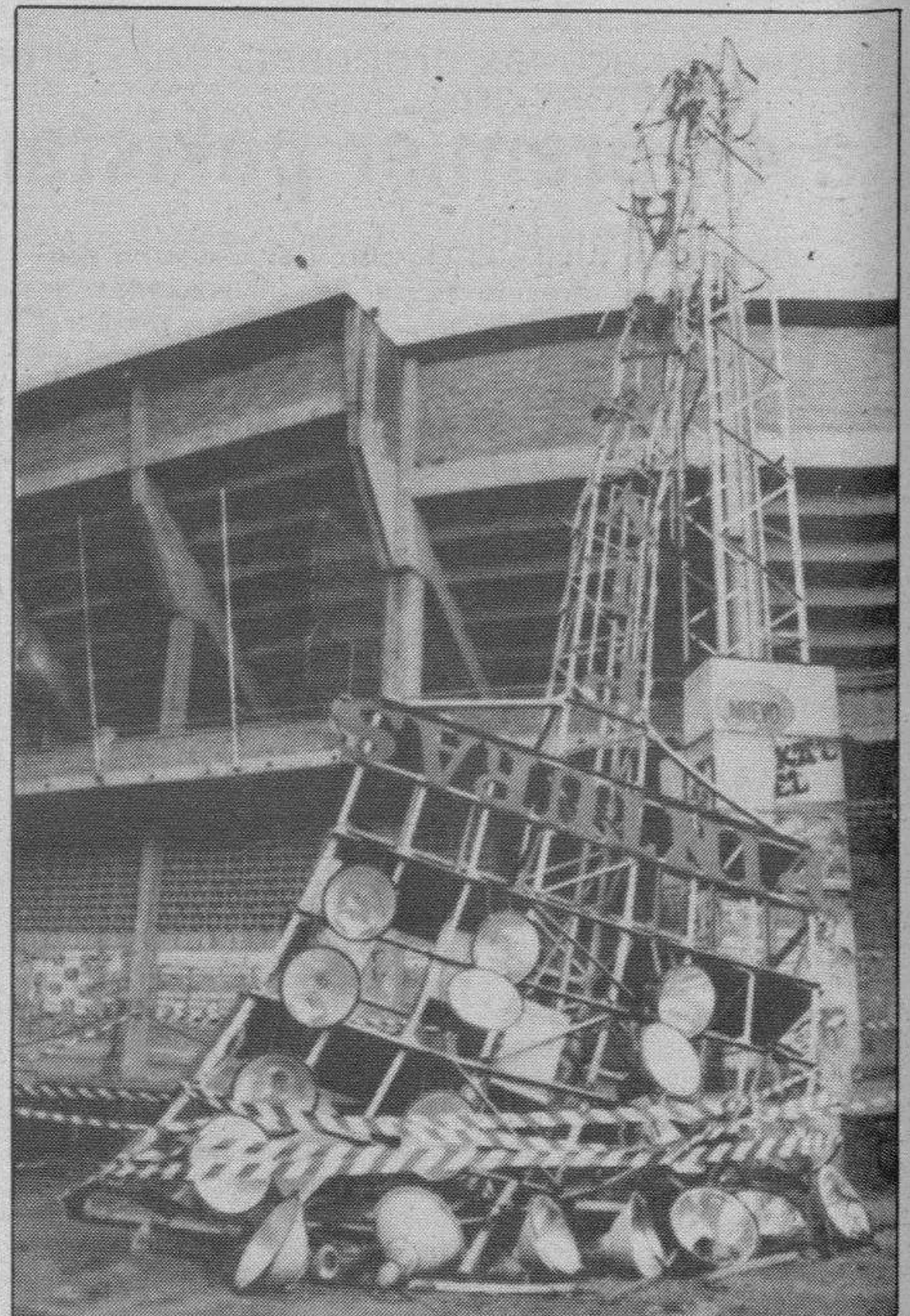
El vendaval causó numerosos daños en Pamplona. Una de las torres de iluminación del estadio de fútbol «El Sadar» fue arrancada por el viento.-Telefoto Efe.
