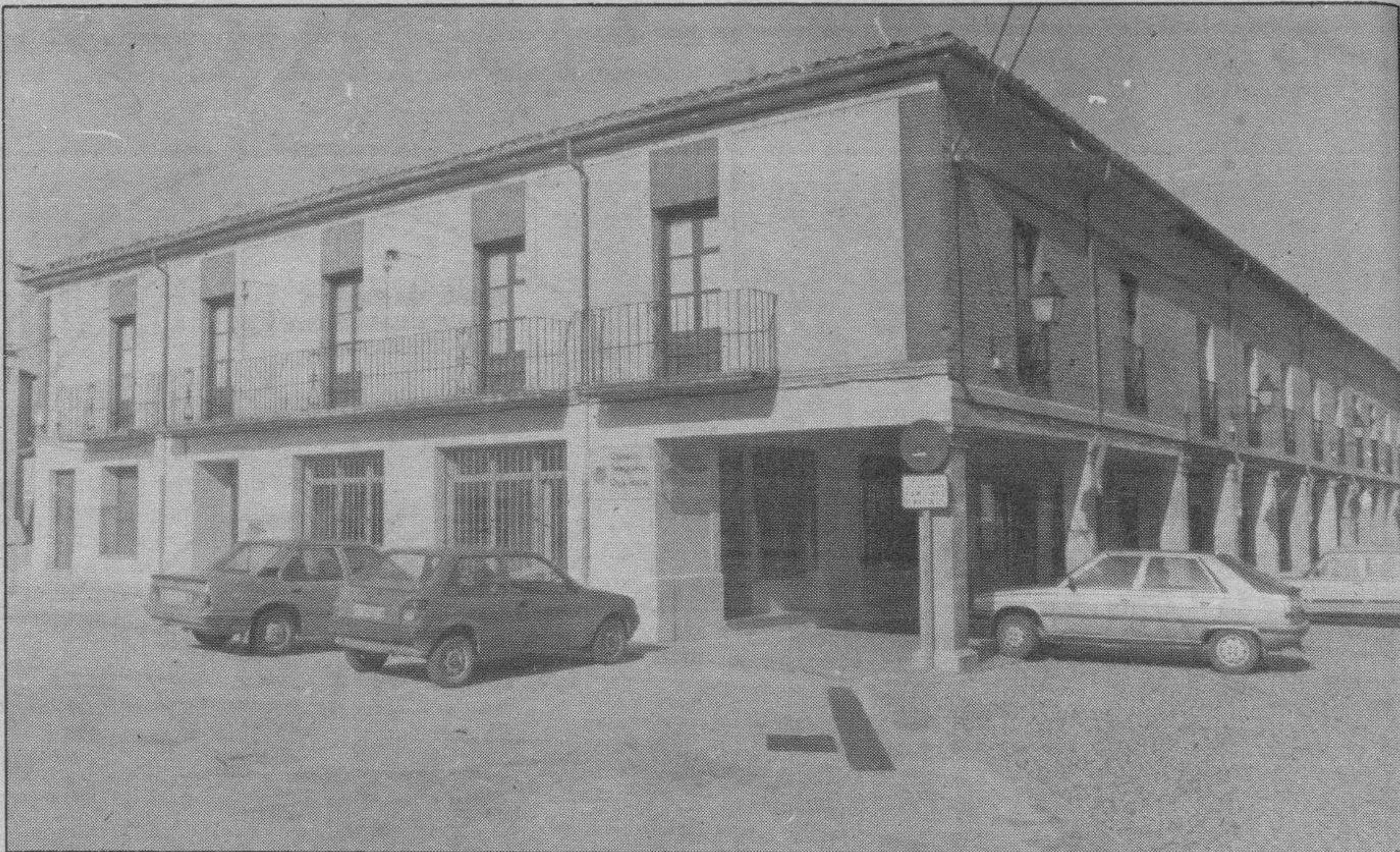
Vista de las nuevas instalaciones. Foto Luis.
