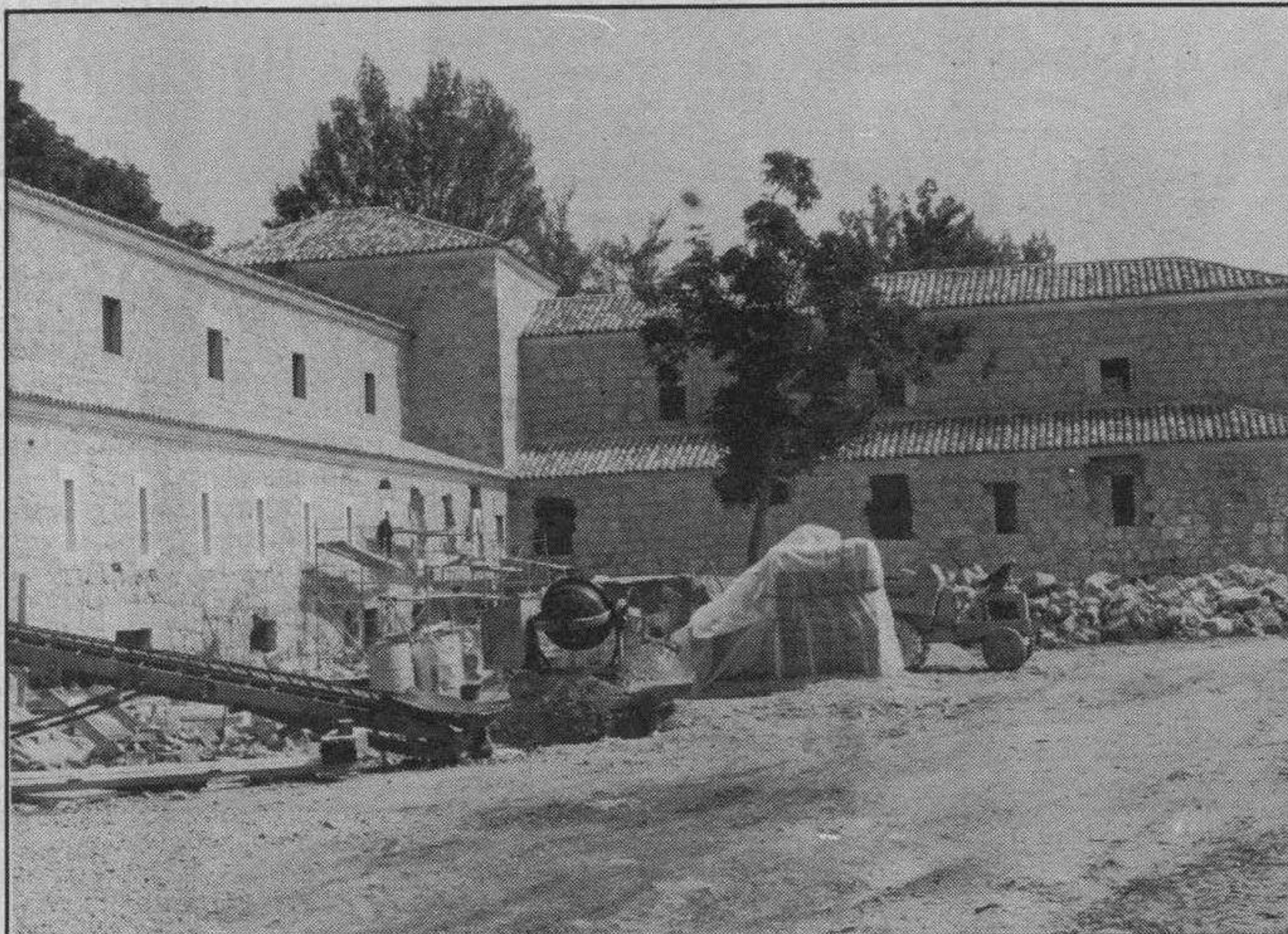
A pesar de la polémica suscitada, las obras de restauración del Hospital del Rey siguen adelante. (Foto L. Matías)
