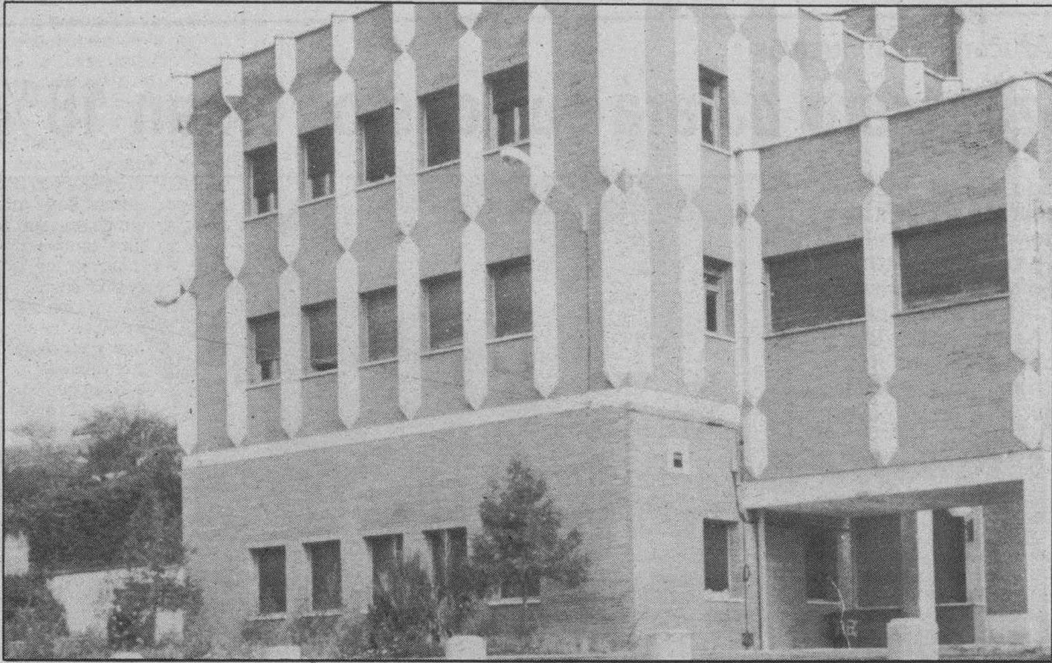
Los primeros pasos para la construcción de la residencia de ancianos se han dado. Ahora todo depende de las tramitaciones que el Ayuntamiento realice. Tras ellas desaparecerá este edificio, el antiguo hospital de Santiago. Foto Truchuelo.
