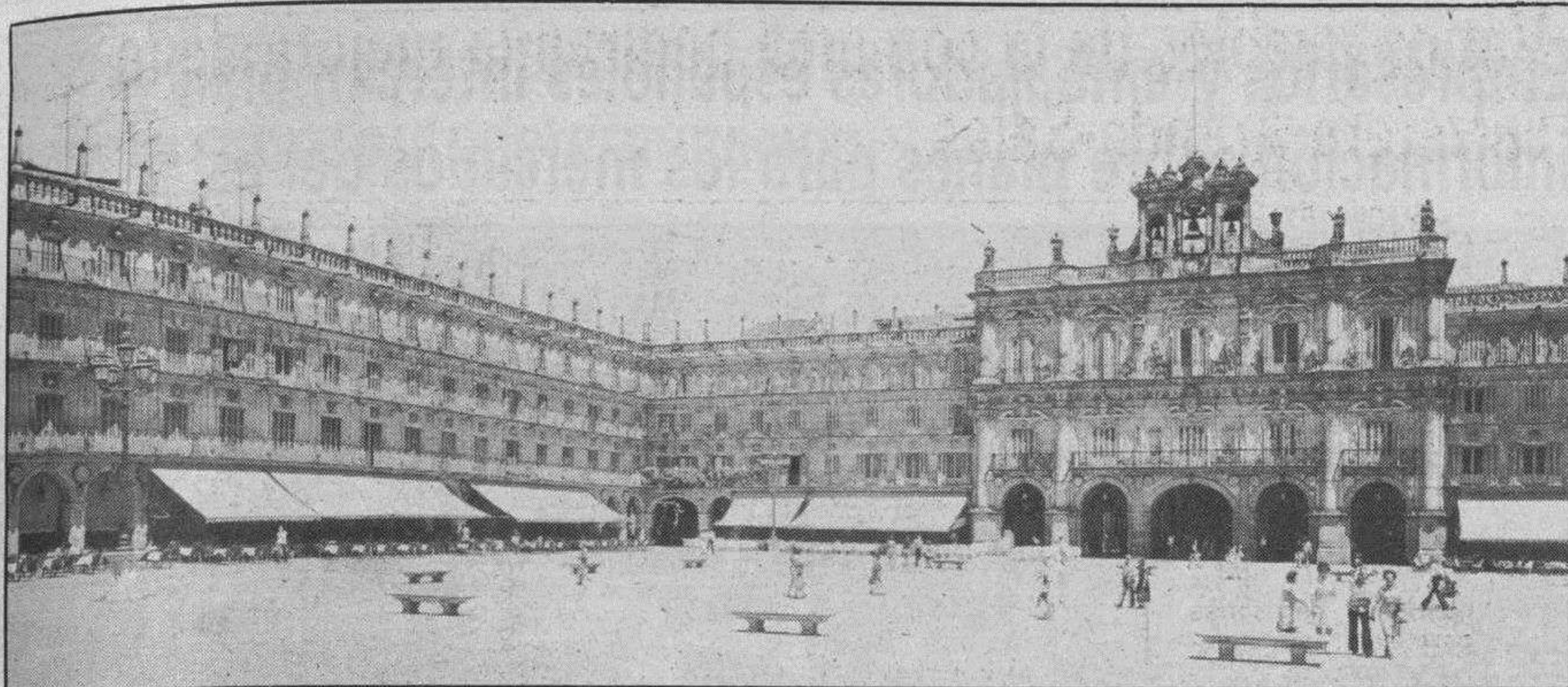
El exceso de celo por la buena conservación ha hecho que se suspenda la restauración de las murallas de la bellísima Plaza Mayor de Salamanca.
