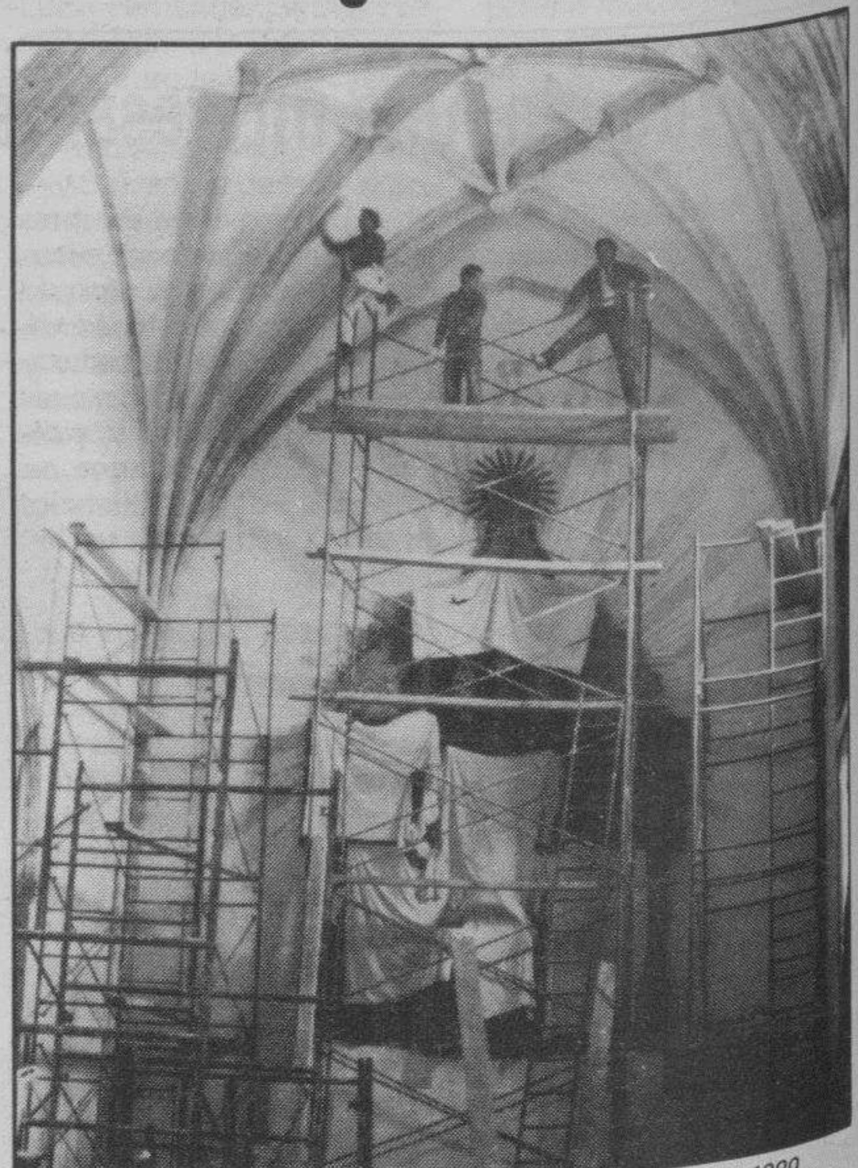
Obras de limpieza en el interior de la iglesia. Abril 1989.
