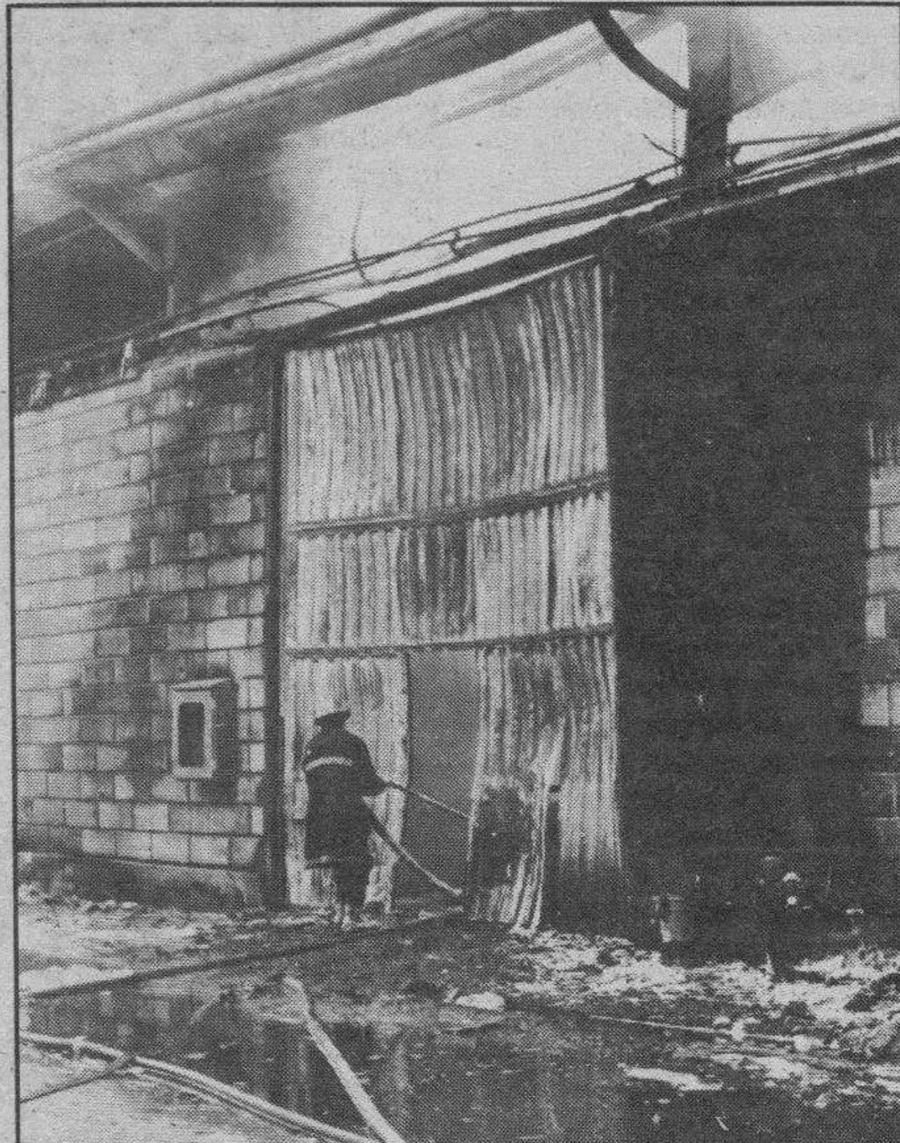
Puerta abarquillada de la sala de calderas donde se originó el incendio. Un bombero sostiene la manguera.
