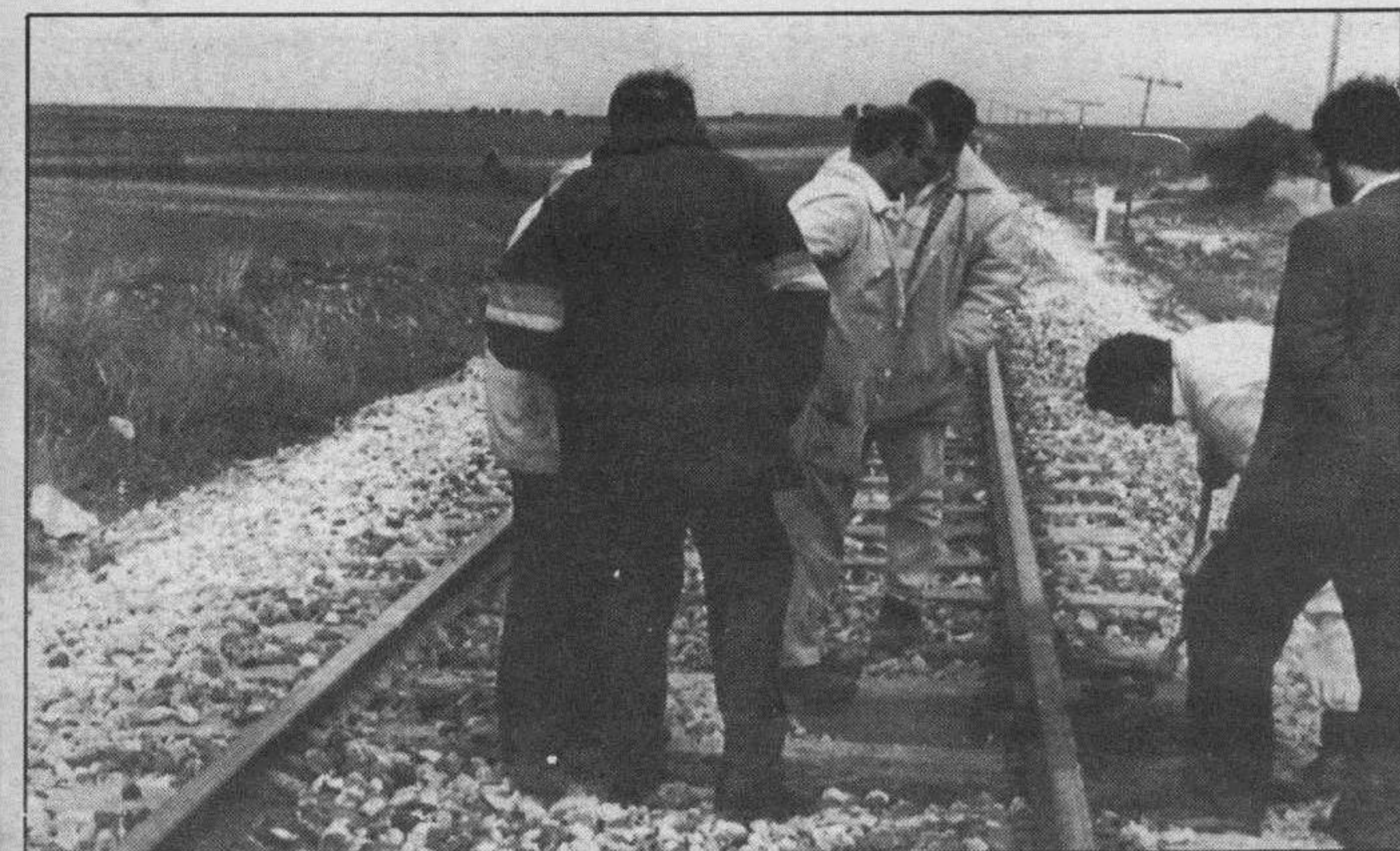
Un grupo de trabajadores de Renfe reparando el tramo de vía entre Santa Cruz de la Zarza y Villarrubia de Santiago, en el kilómetro 36,950 de la línea férrea Aranjuez-Cuenca. Después de que estallara una carga de escasa potencia. Telefoto Efe.
