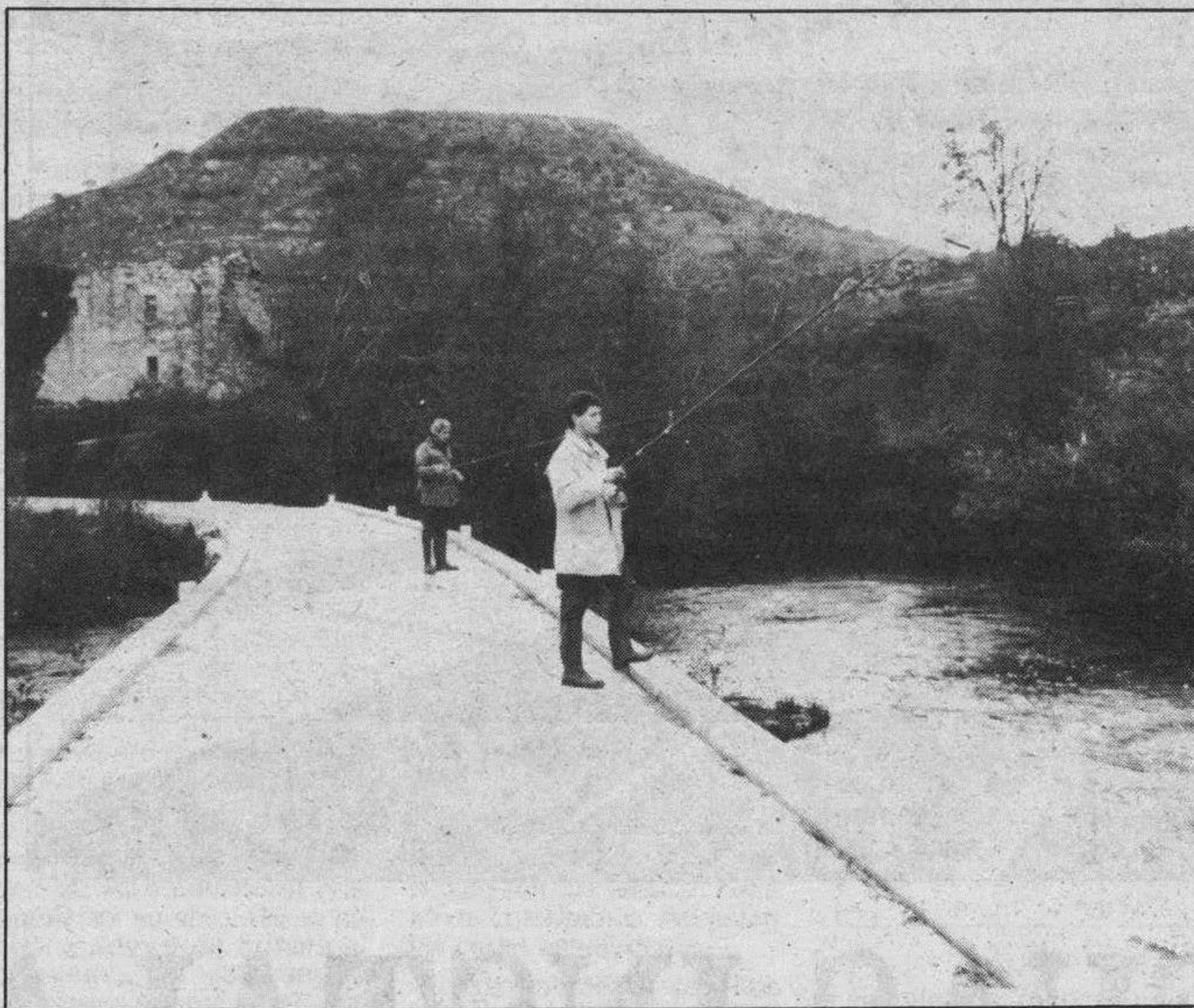
Puente de Manzanedillo. Aficionados pescando en el río Ebro. Foto J.J. Presa
