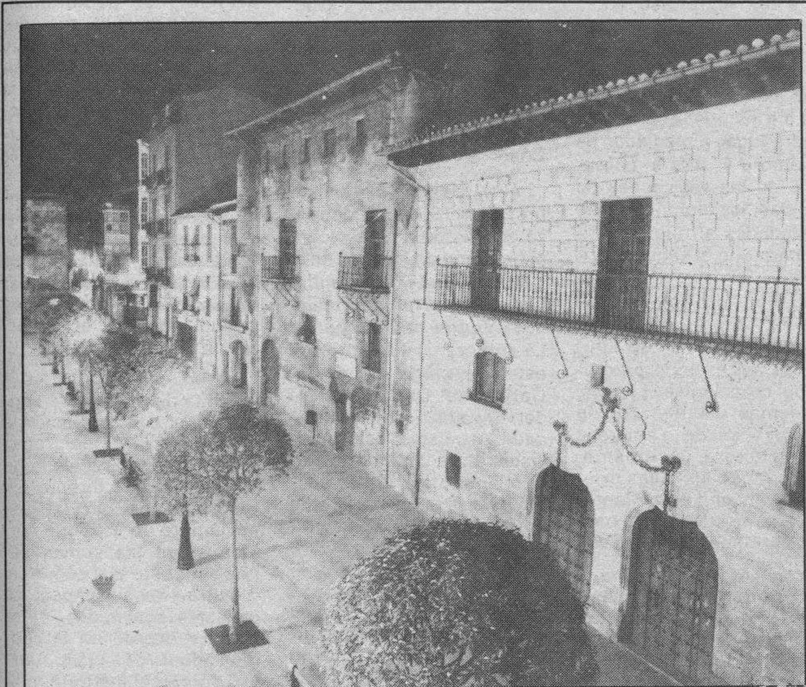
Continúa el arreglo de fachadas de la Plaza de España. — Ya son seis las fachadas que se han arreglado o recuperado en la Plaza de España. Actualmente, se está ultimando la de la Casa Consistorial que queda magnífica y la de la casa número 7, que está dando más trabajo del previsto ya que su fachada tiene un complicado arreglo, al estar formada en la parte alta por ladrillo de «galleta» y el resto de piedra, pero esta piedra no es igual en conjunto y de ahí la lentitud que lleva su arreglo. En la fotografía vemos la parte izquierda de la plaza en la que figuran dos de los edificios más notables de la ciudad, como son el Palacio de la Conseda de Miranda o Casa de las Cadenas y el también palacio, actualmente Casa Rectoral de la parroquia de Santa María, que también serán restaurados.
