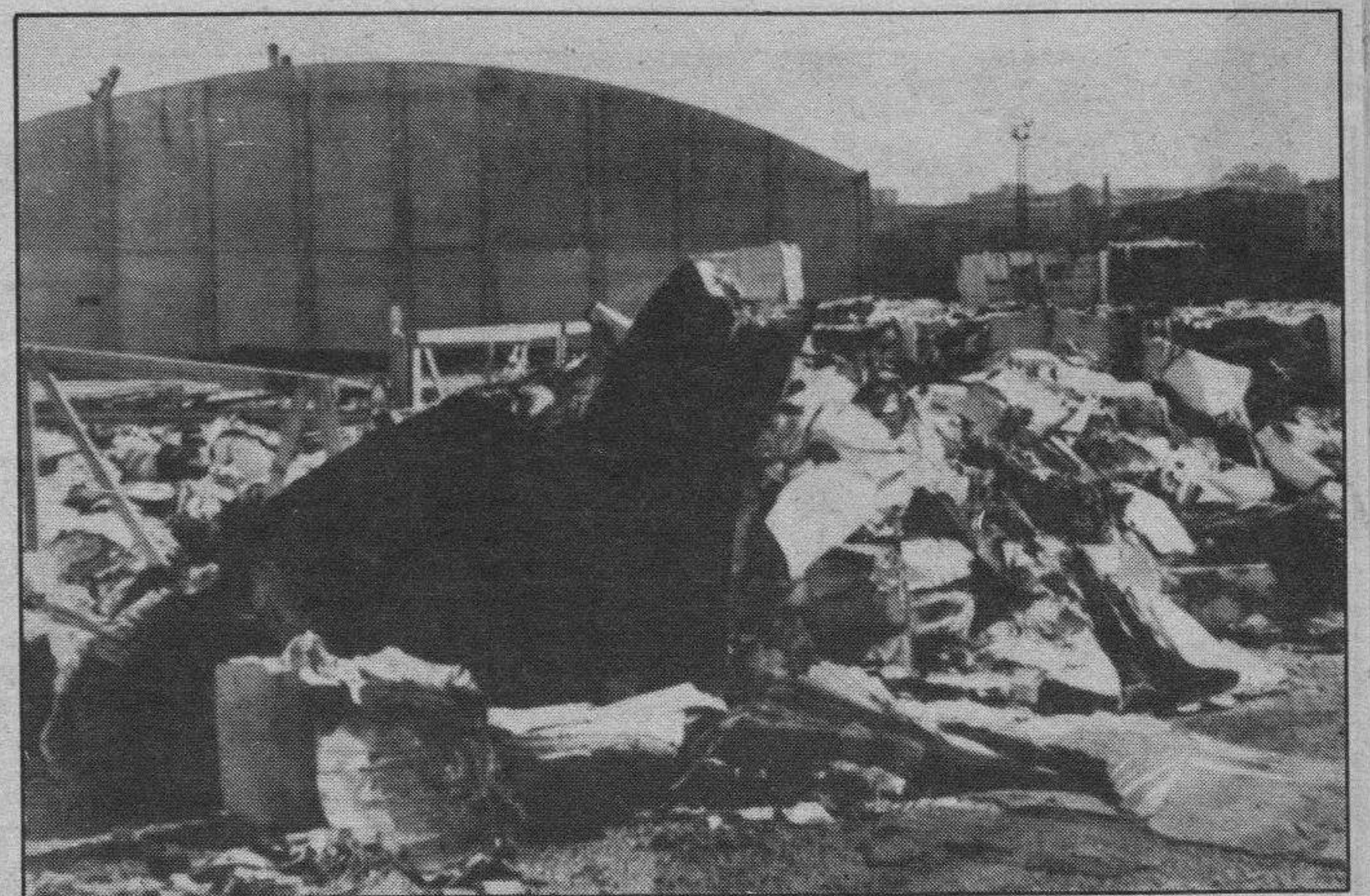
Estado en que quedó el almacén del puerto de Pasajes, que esta madrugada fue incendiado por uno o por varios desconocidos, ocasionando daños valorados en unos cincuenta millones de pesetas
