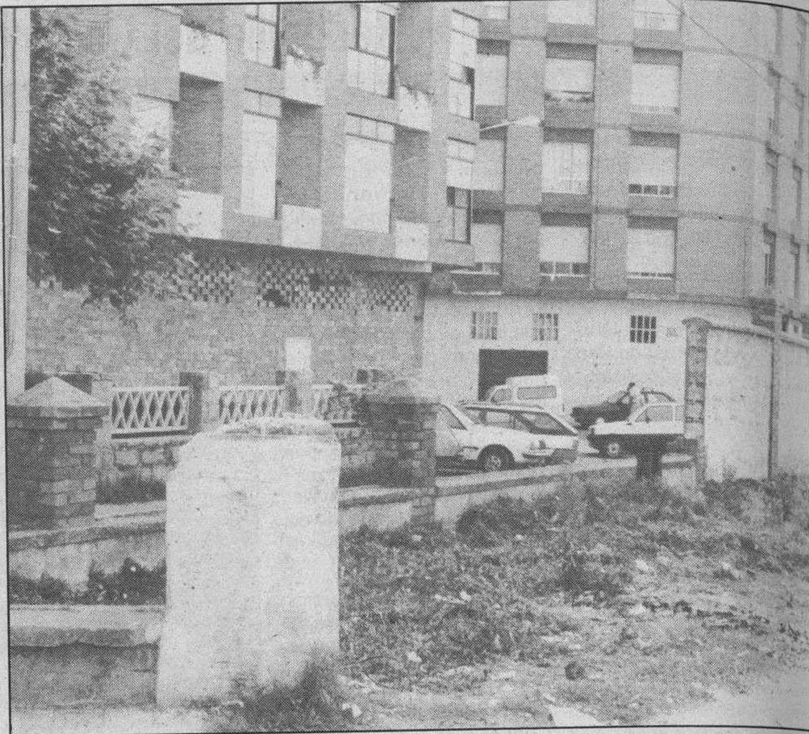
Numerosas obras urbanísticas en marcha. — ya apenas quedan vestigios de las tapias que flanqueaban lo que fuera tramo del ff. cc. Bilbao-Castejón y al mismo tiempo se realizan las primeras explanaciones para ir perfilando la Ronda del Ferrocarril. Simplemente con la desaparición de las tapias, el centro de la ciudad ofrece otro aspecto de más amplitud, de descongestión. Por otra parte, han comenzado las obras de nuevas pavimentaciones en la calle del Olmo, Los Hornos y de remodelación de la Plaza de Cervantes. En esta se van a adicionar las aceras de Real Allende, desde Leopoldo Lewin hasta lo que será la Ronda del ferrocarril, obras que unidas a las que se harán en la Plaza de Prim, embellecerán el centro del casco urbano. En cuanto al barrio de Aquende, ya de cimos que han comenzado las obras en la calle de Los Hornos y, seguidamente comenzarán las de las plazas de Santa María, Mercado, Escuelas y accesos, que pasarán a ser peatonales. En la foto de Truchuelo un aspecto de la zona afectada por el derribo de las tapias, una de las cuales aún se ve a la derecha, pero que al día de hoy, ya ha sido derribada.
