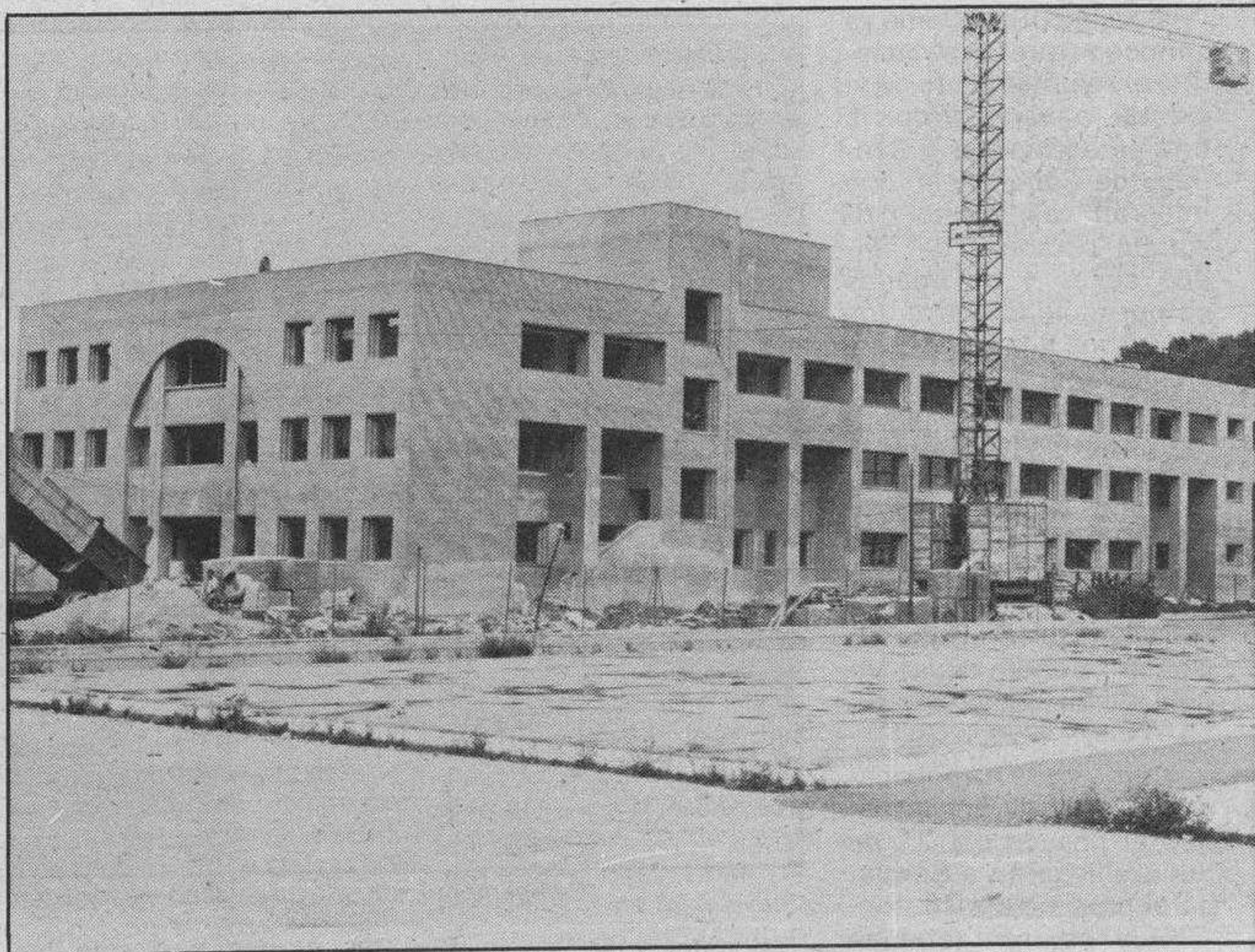
Nueva sede de la Escuela, que entrará en funcionamiento el curso 1988-89.
