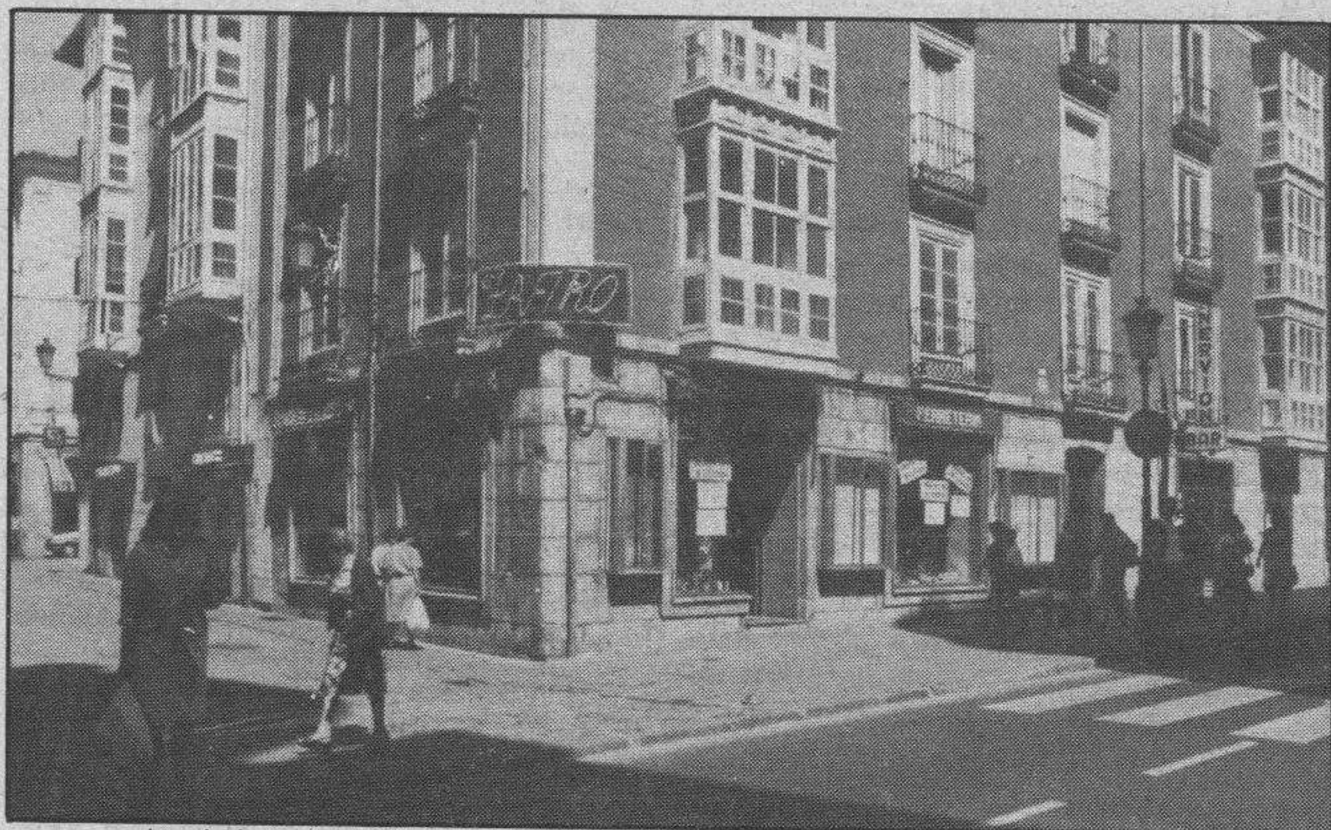
Los bajos comerciales y los dos primeros pisos, han sido adquiridos por la «Caixa».
