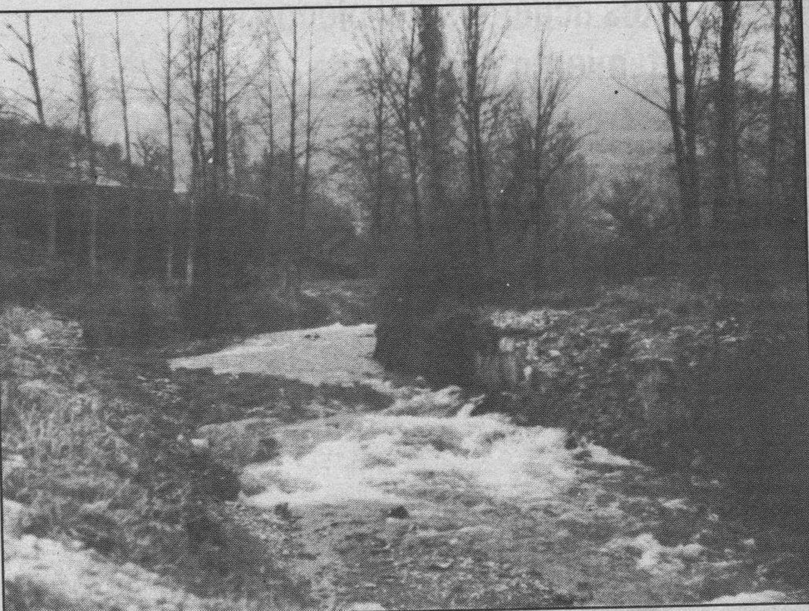
Aspecto del estado en que se encuentra actualmente. (Se observan restos del molino en la parte derecha). Después de su demolición.
