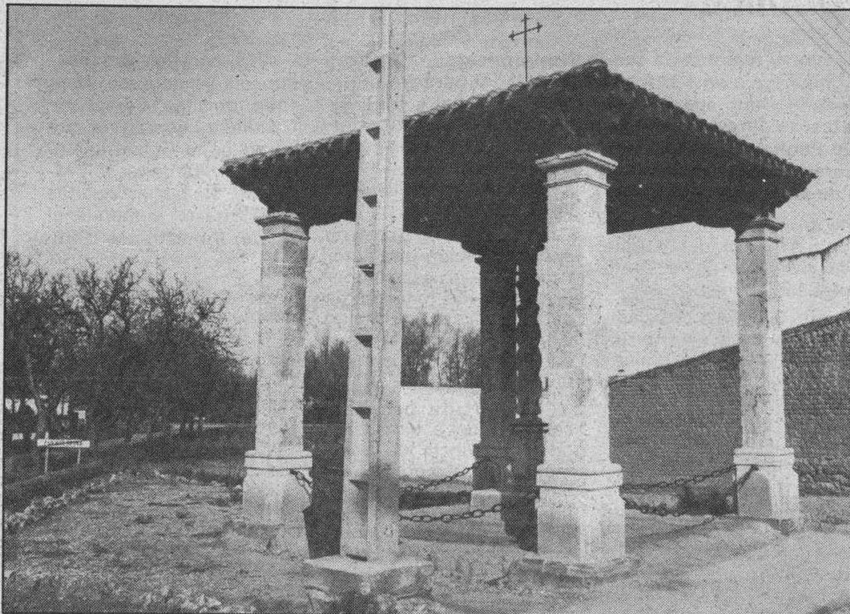
Sin palabras... Este poste que aparece en el Humilladero, de Fuentespina, desdice del conjunto. Corresponde a un tendido eléctrico. Foto Lara.
