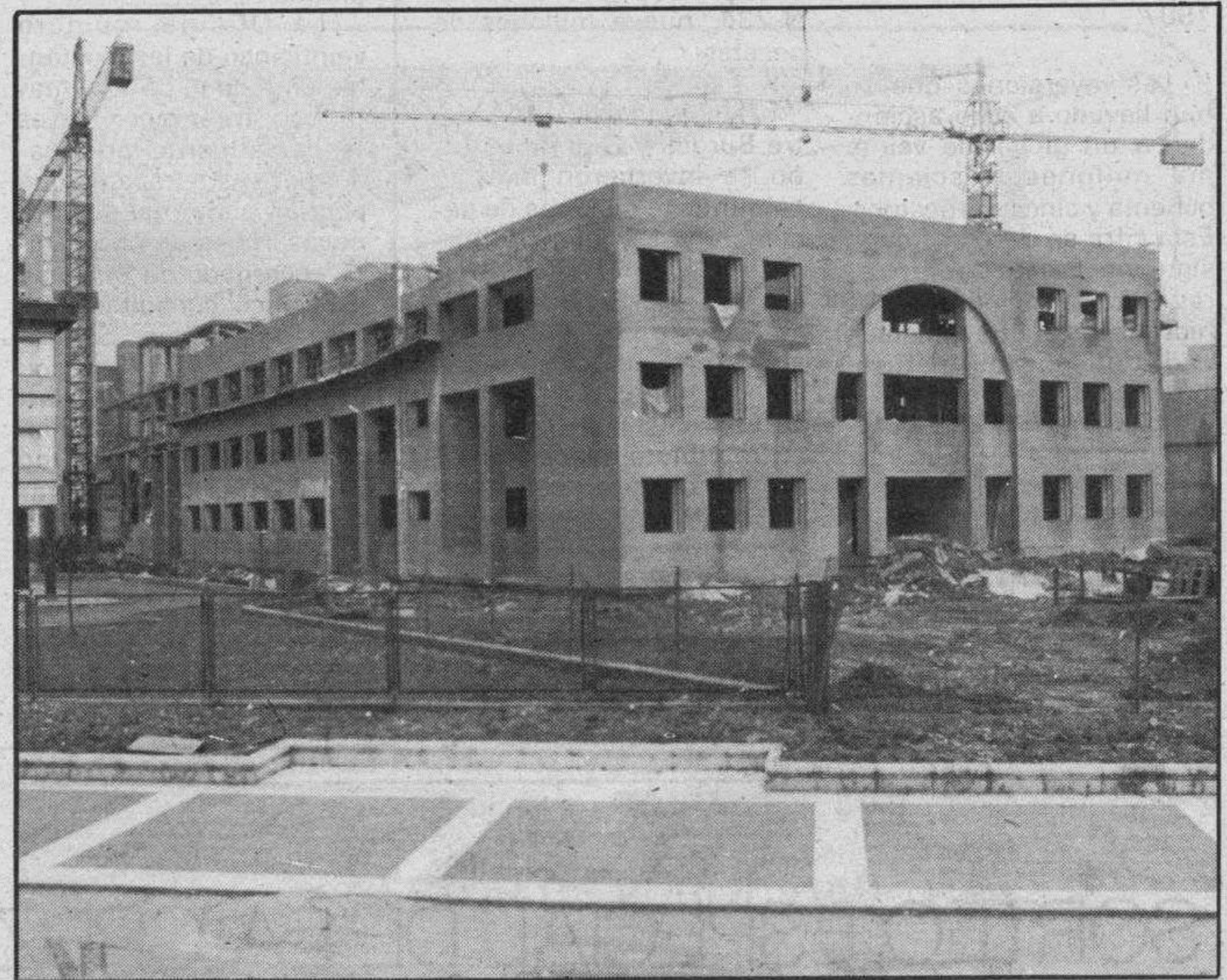
Aspecto de las obras de la nueva Escuela Oficial de Idiomas
