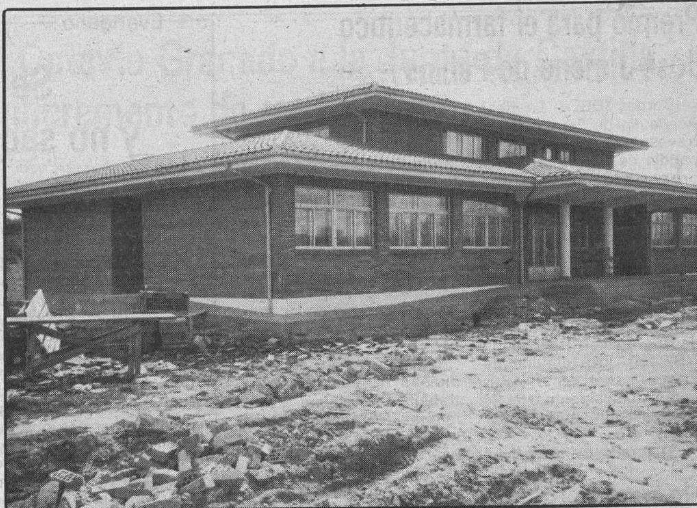
El centro de salud de Salas, en fase de construcción muy avanzada, entra en las previsiones de equipamiento. —Foto L.M.
