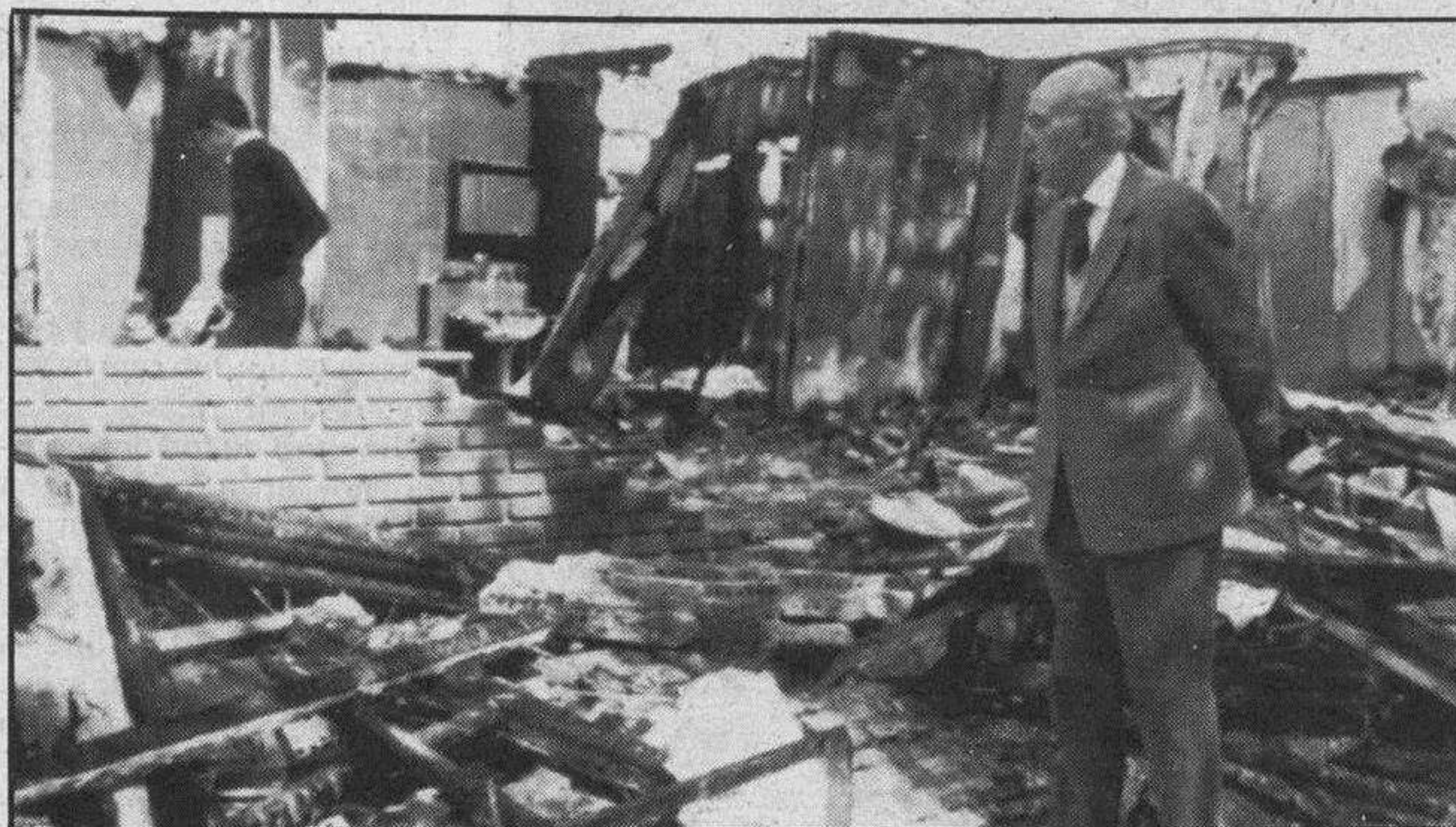
Hoyo de Manzanares (Madrid). El chalet que Joaquín Ruiz Giménez ex-Defensor del Pueblo poseía en la localidad madrileña de Hoyo de Manzanares resultó con siniestro total después de arder completamente. Al parecer las causas del incendio fueron por el recalentamiento de la chimenea. Ruiz Giménez observa las ruinas de su chalet tras el siniestro.
