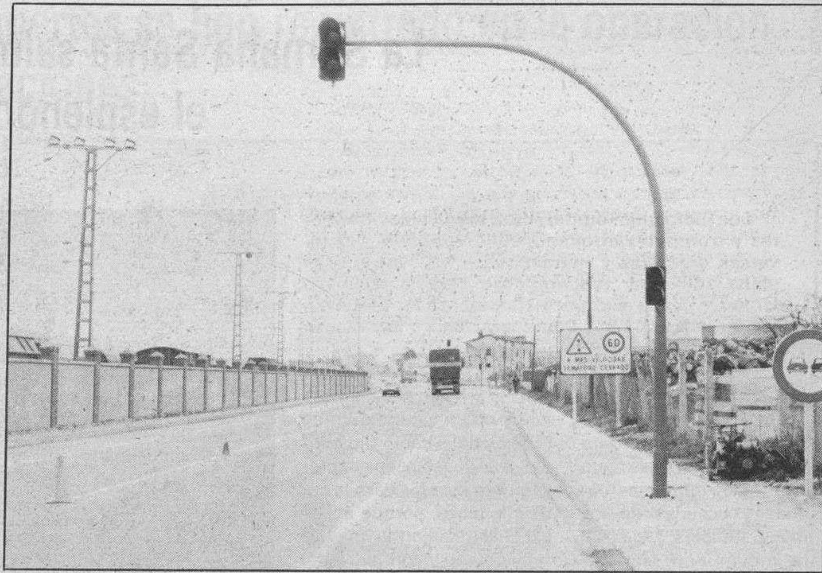
Vista de la carretera N-1 en «Las Matillas». Foto Truchuelo.
