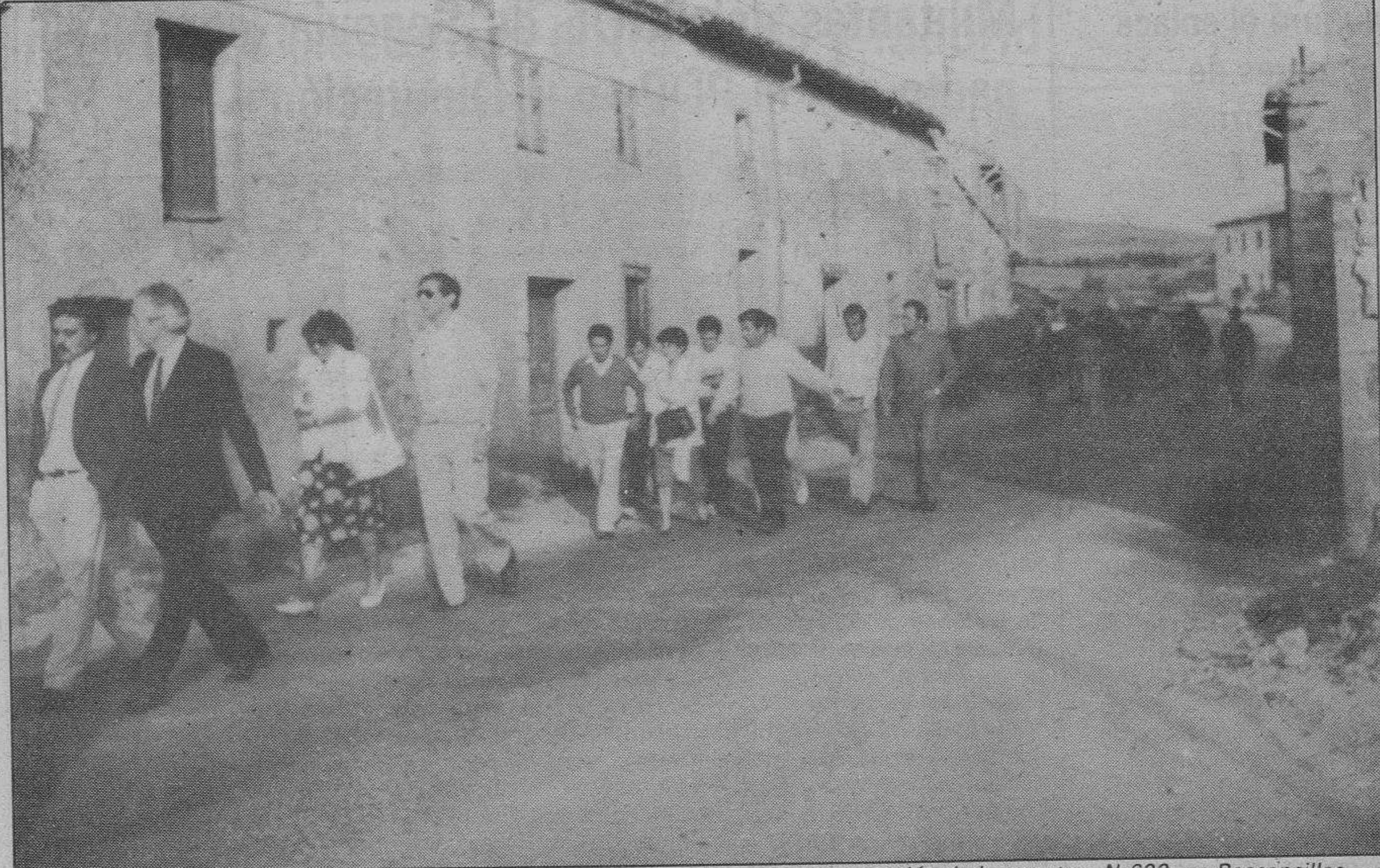
El anterior gobernador civil, David León Blanco, recorriendo las obras de pavimentación de la carretera N-622, en Basconcillos del Tozo. — F. Archivo.
