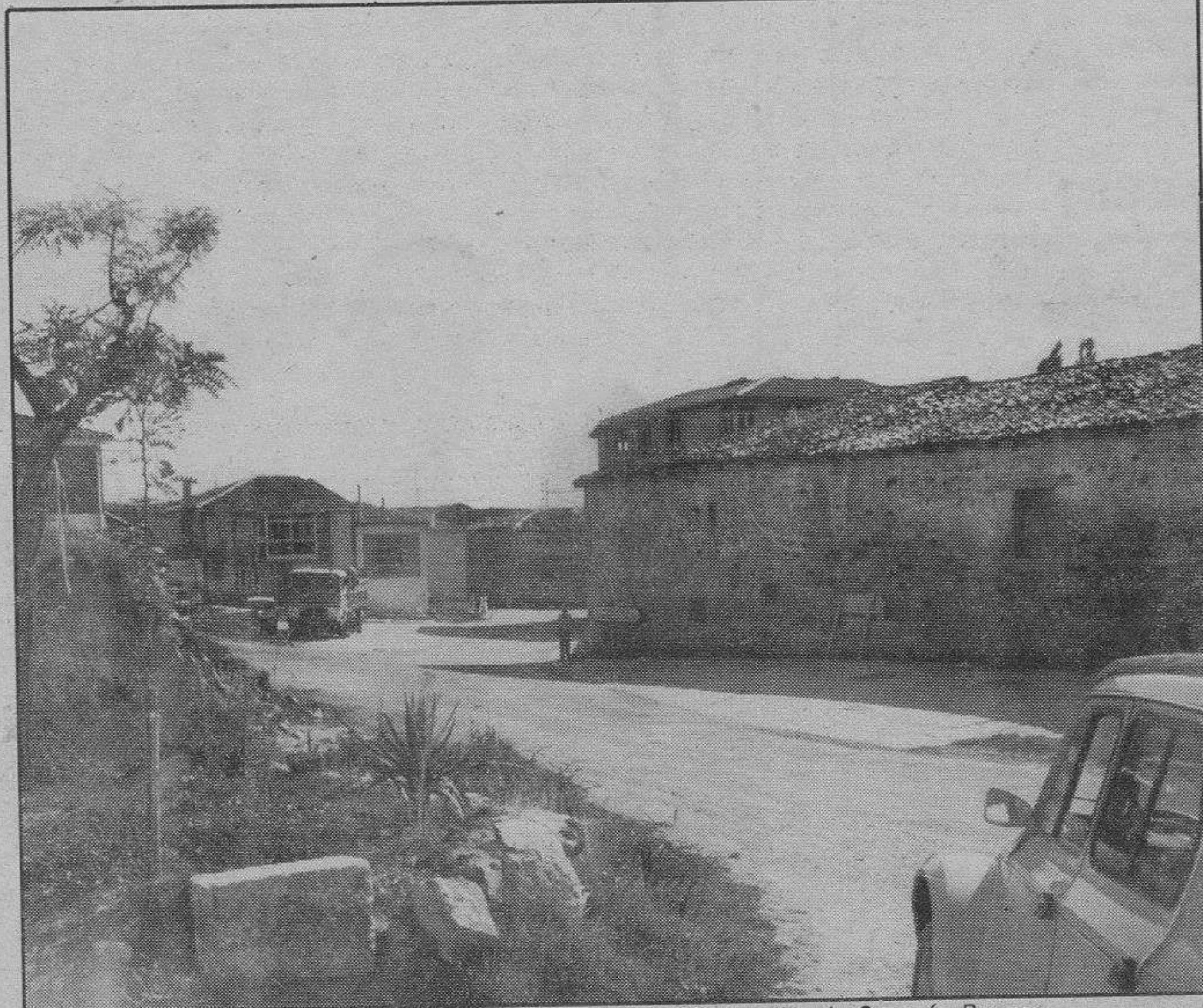
Estado actual de la travesía, en la dirección Aguilar de Campóo-Burgos.
