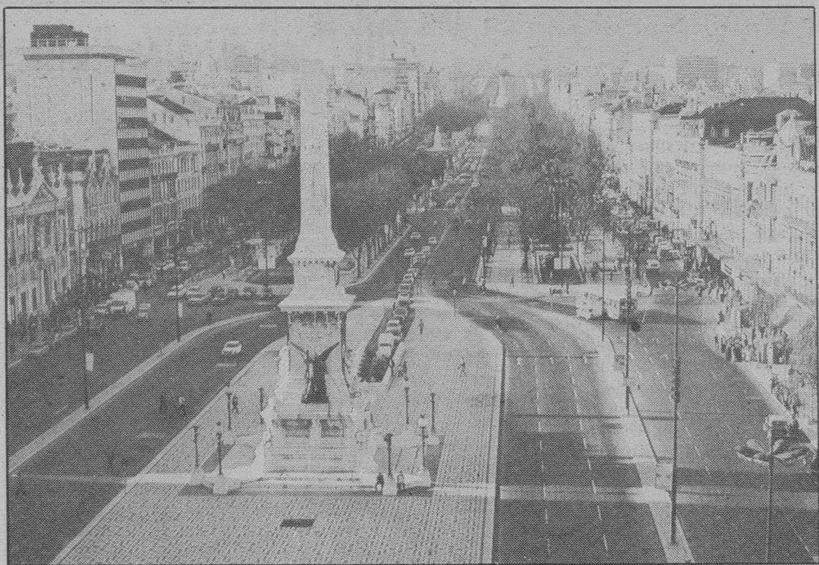
Monumento a los «Restauradores». Lisboa.
