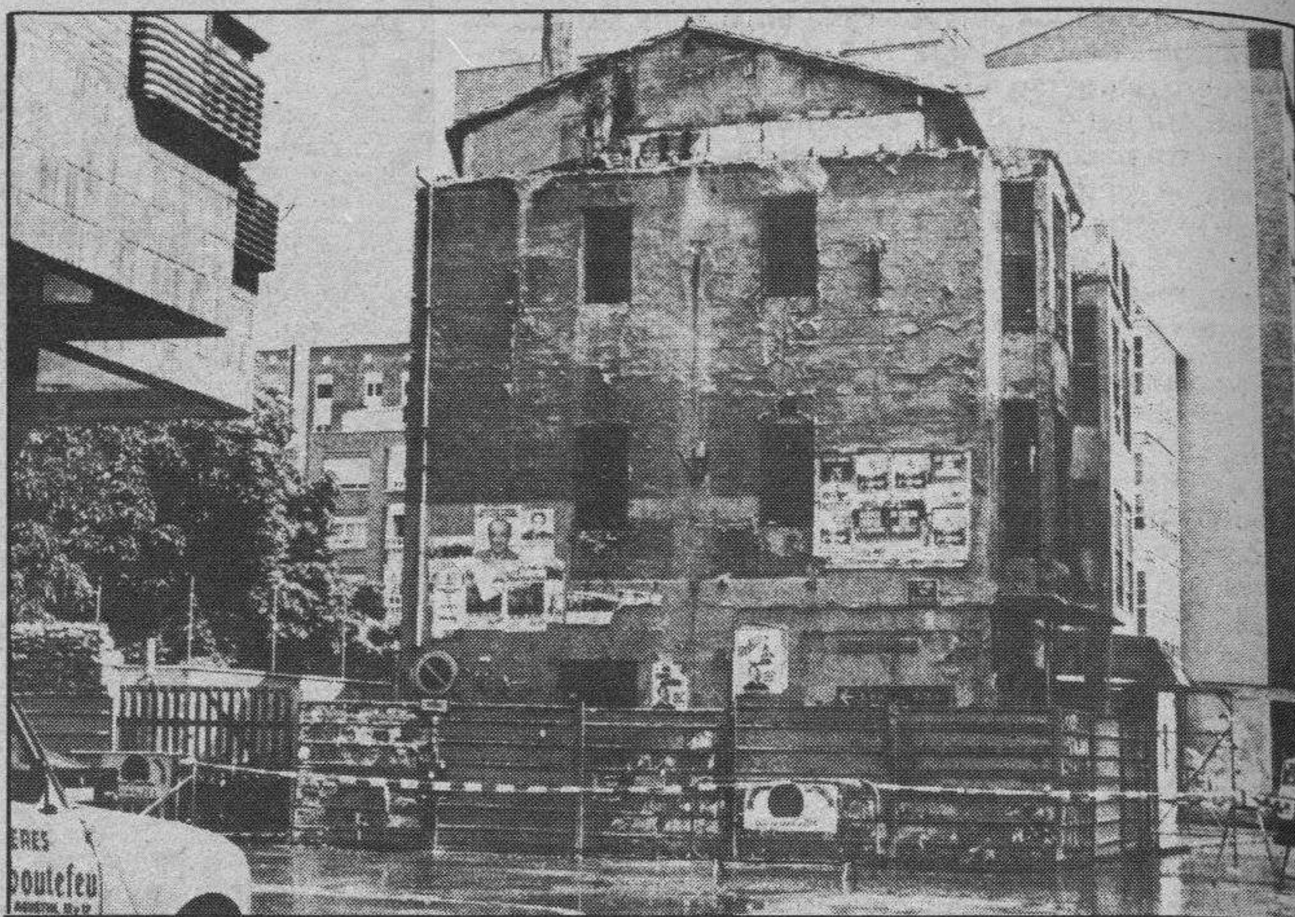
Casa de la zona de San Agustín y Arenal, que está siendo derruida. — Foto Truchuelo.
