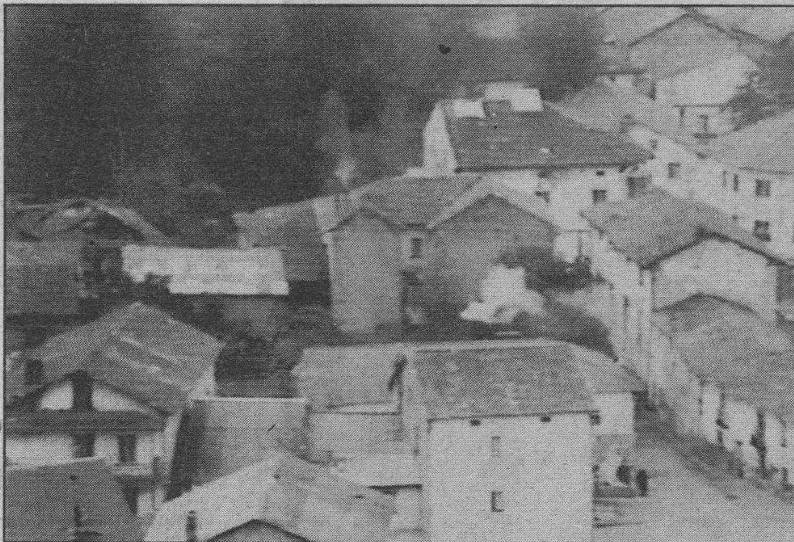
Vista parcial de Riaño cuando aún no se habían iniciado los derribos. F. archivo.
