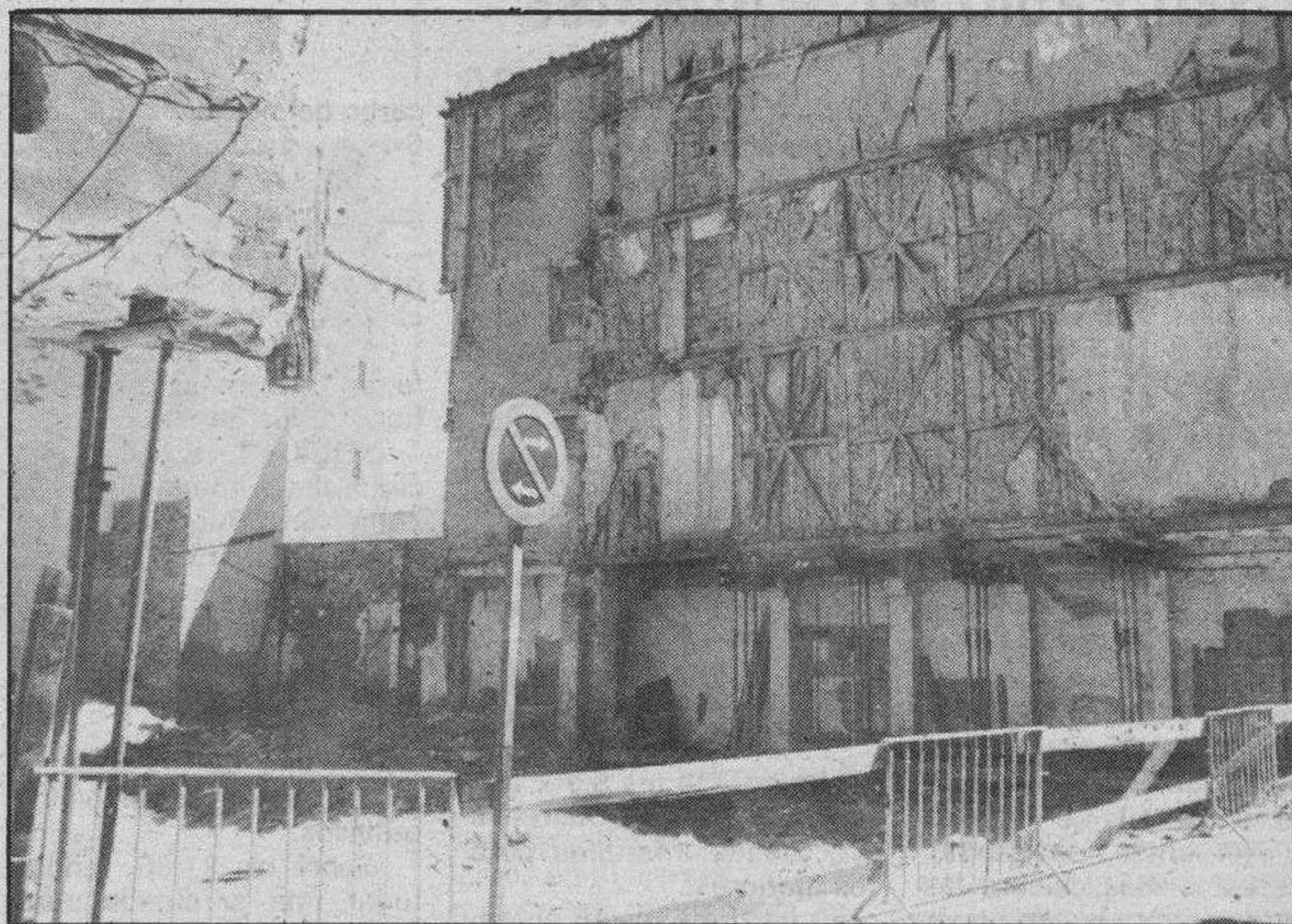
Derribo de casas en mal estado, una tarea urbana necesaria en Aranda. — Foto Lara.
