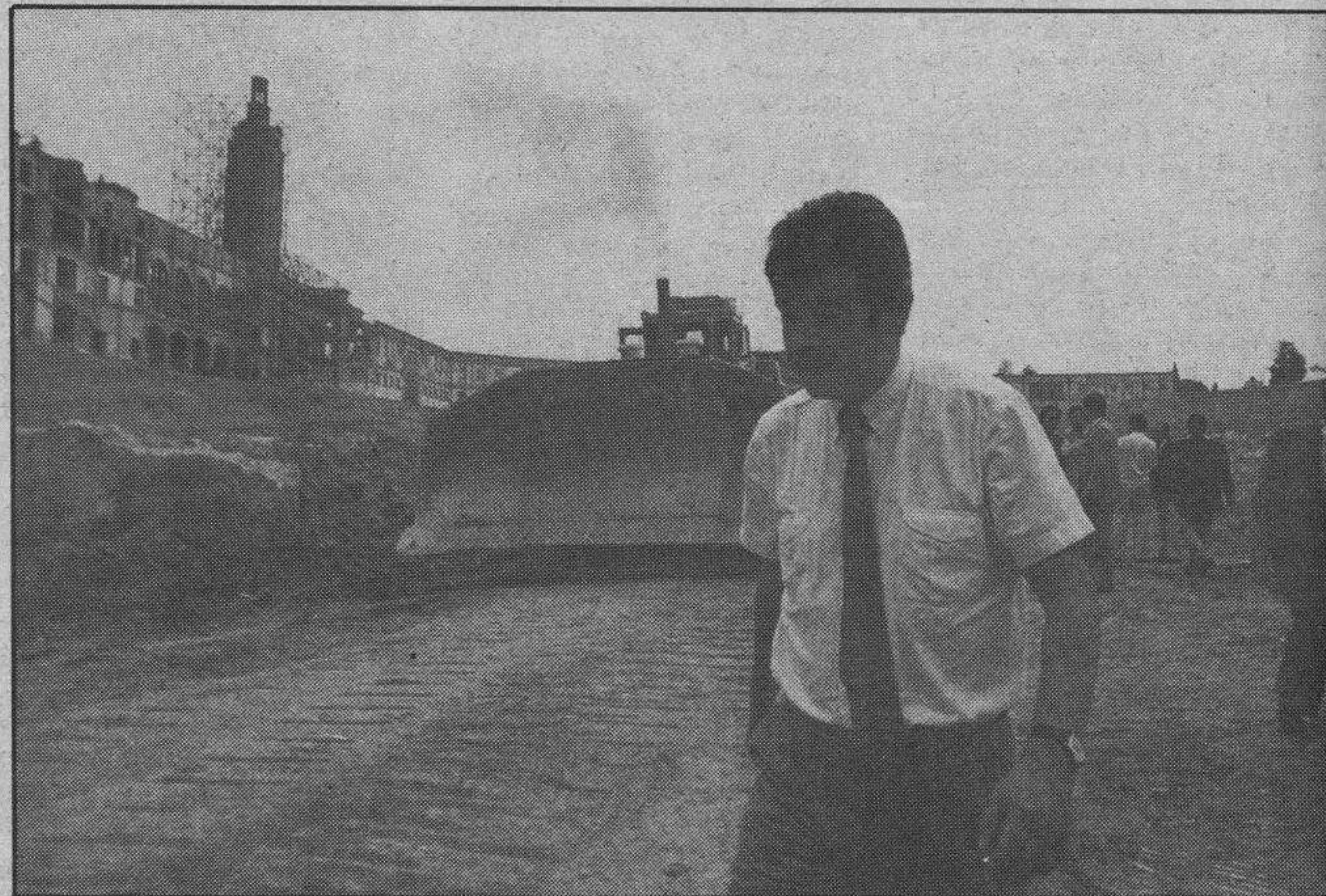
Alrededor de 22.000 millones se invertirán en la finalización del I Cinturón de Ronda. En la fotografía, al alcalde de Barcelona visitando las obras.
