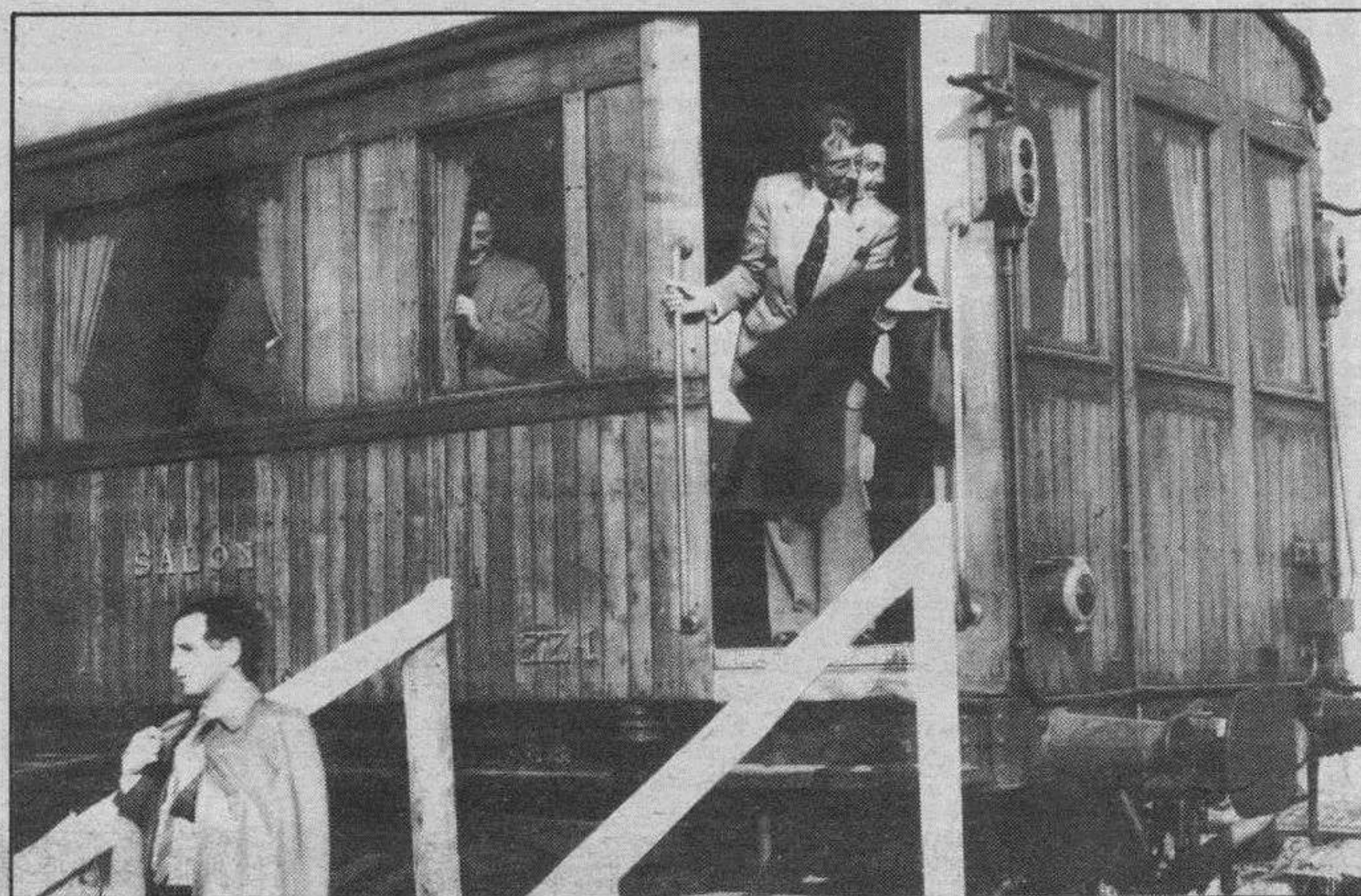
Importante logro ferroviario de Miranda. — Altos jefes de la VI Zona de RENFE con el alcalde de Miranda señor Simón Romanillos y los informadores han visitado las obras de la variante de la línea Bilbao-Castejón, que supondrá que desde el día 31 de Enero deje de pasar por el centro de la ciudad mirandesa el tren. El proyecto ha supuesto 1.276 millones y ya se habla de que ese día sea festivo en Miranda. Una realización importante que desde la capital celebramos, al tiempo que exigimos que en el nuevo año comience también a resolverse este gravísimo problema de Burgos. En la foto de Truchuelo, un momento del recorrido informativo por el túnel de «La Picota».
