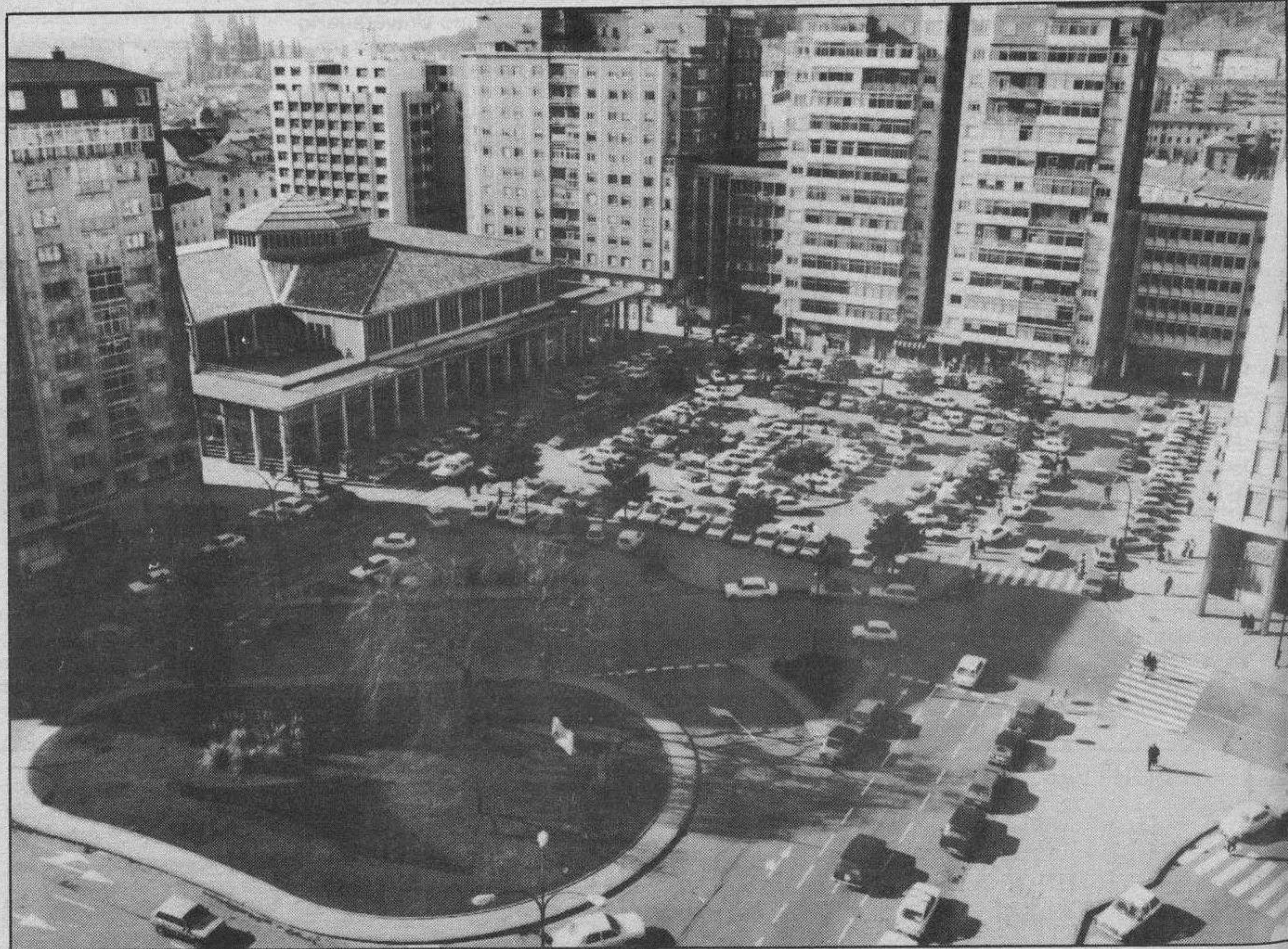
Con el nuevo año, la Plaza de España estrenará su nueva urbanización, tras la construcción del aparcamiento subterráneo
