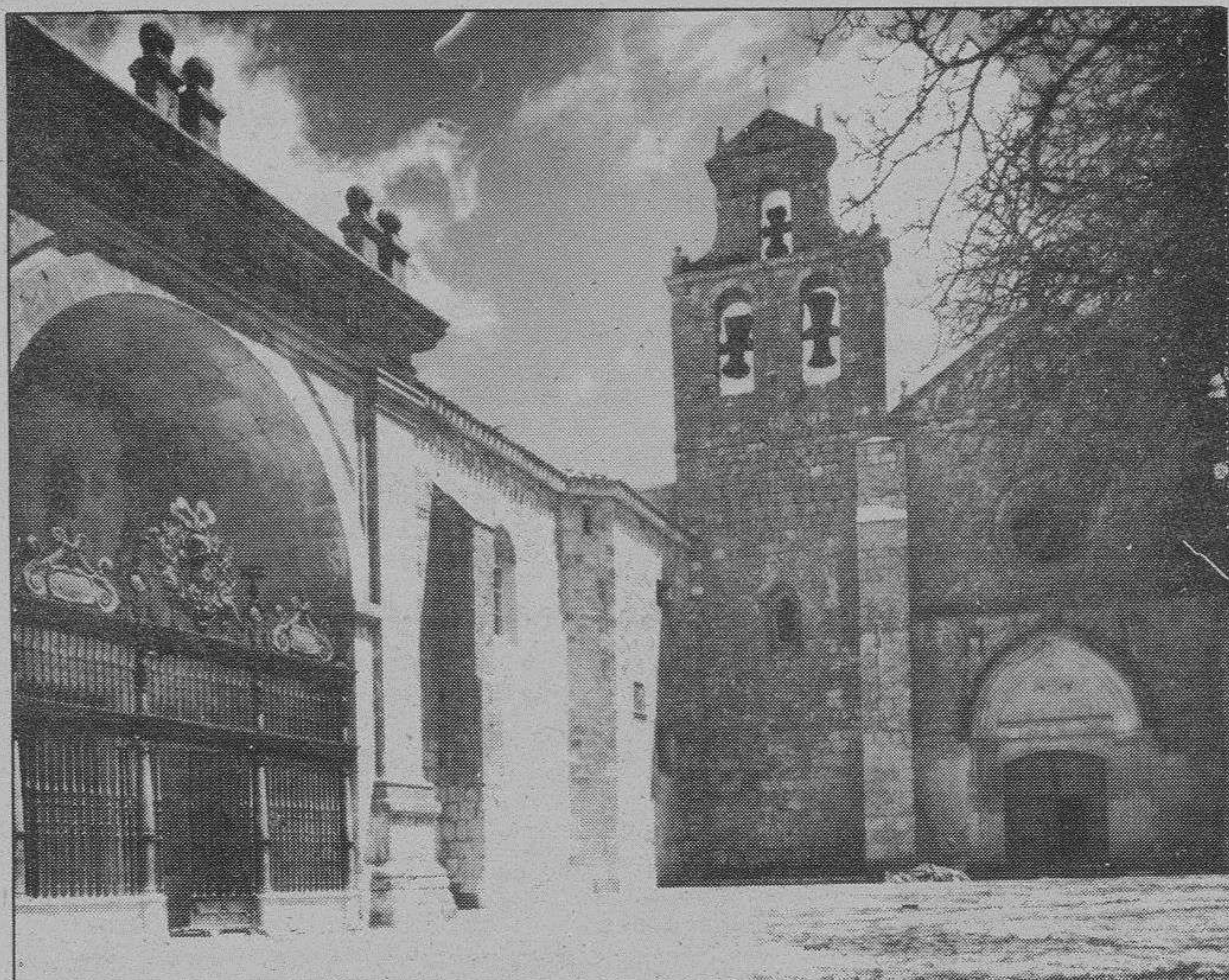
Fachada principal del Monasterio de San Juan de Ortega.
