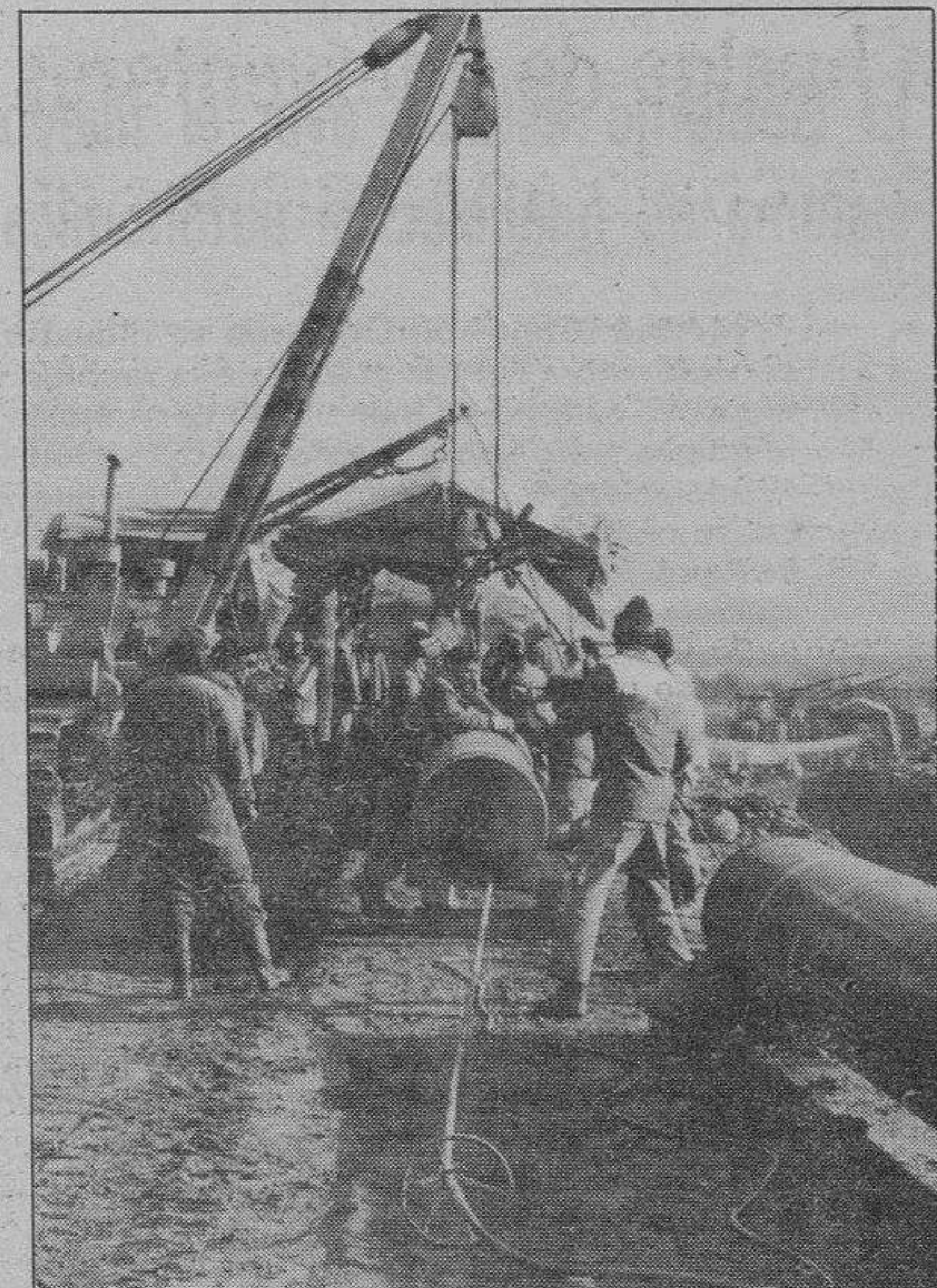
Construcción del gasoducto, proyecto subvencionado por el FEDER.
