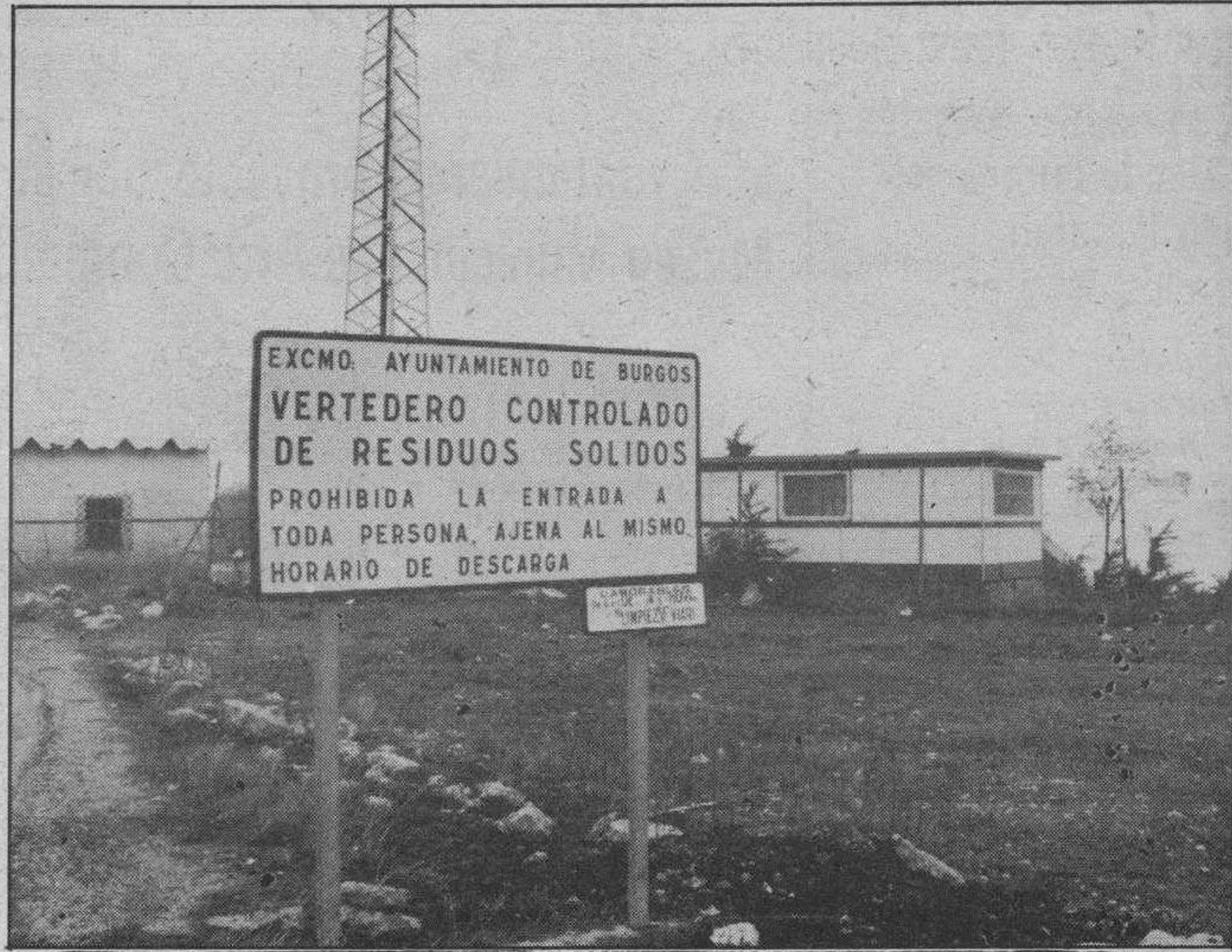
Poco más de tres millones y medio de pesetas costarán las obras de acondicionamiento
