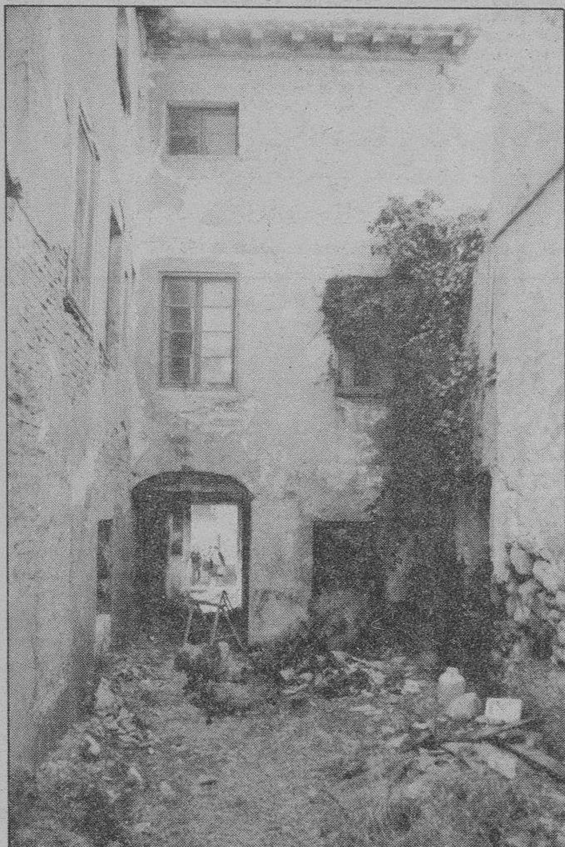
Aspecto de un pasaje en la Calleja Revenga, donde han comenzado las obras de acondicionamiento. (Florentino Lara).
