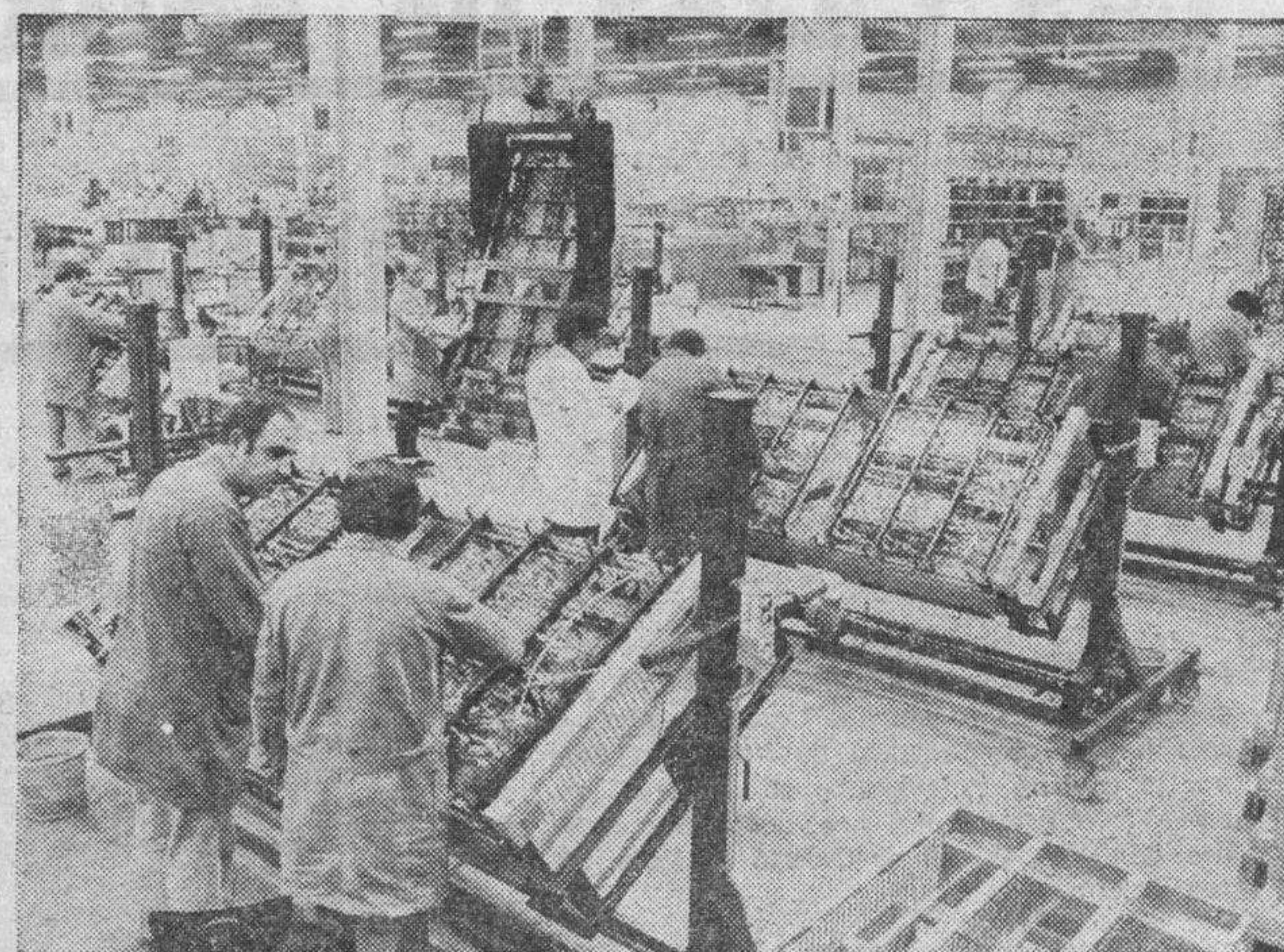
Fabricación de bastidores del Sistema 12 en la factoría de Standar Eléctrica en Toledo.
