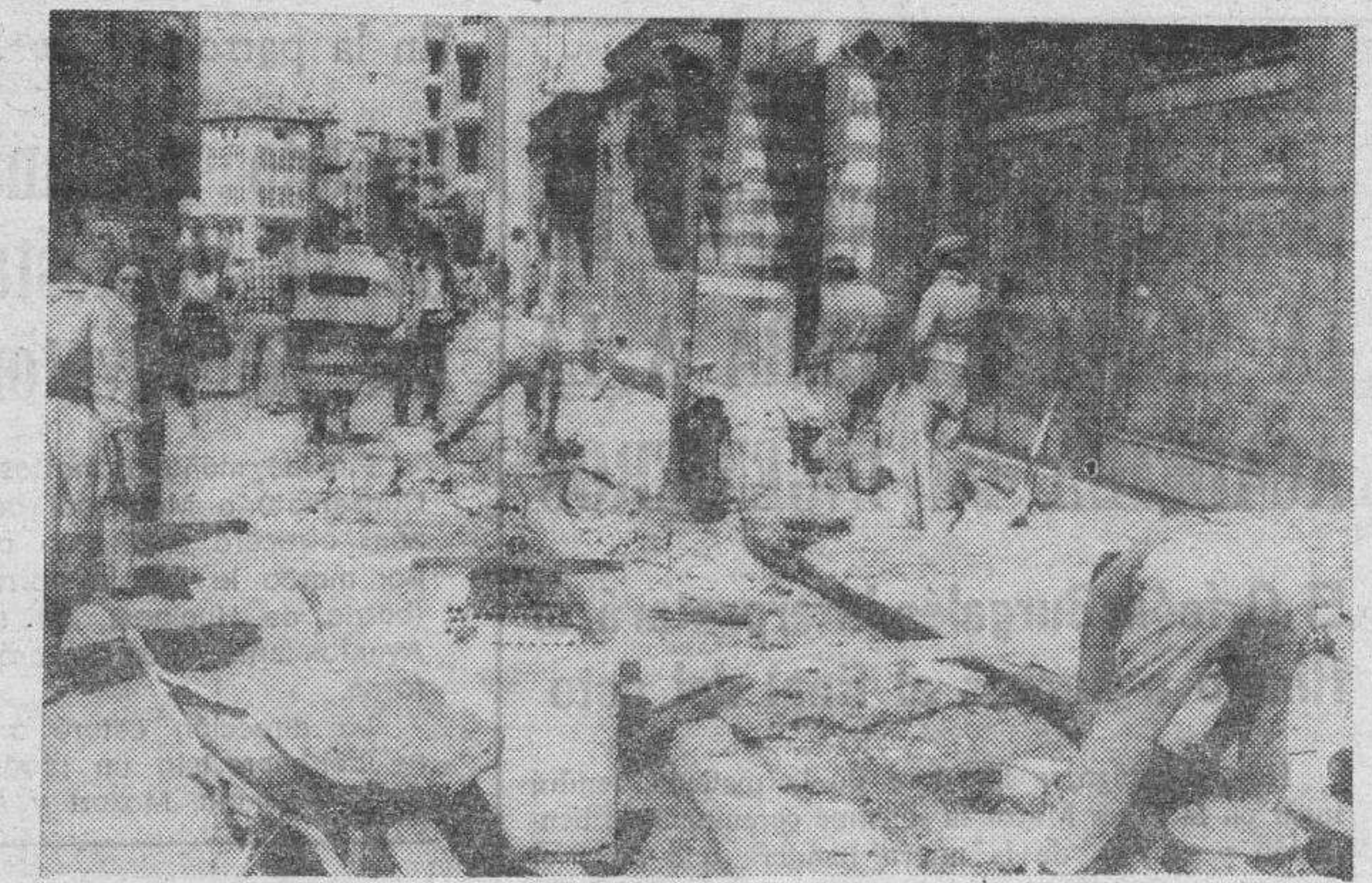
Gran actividad en la calle General Mola en las obras de mejora de calzadas y aceras que se ejecutan estos días dentro del plan previsto para la zona Sur. — (Foto FEDE).
