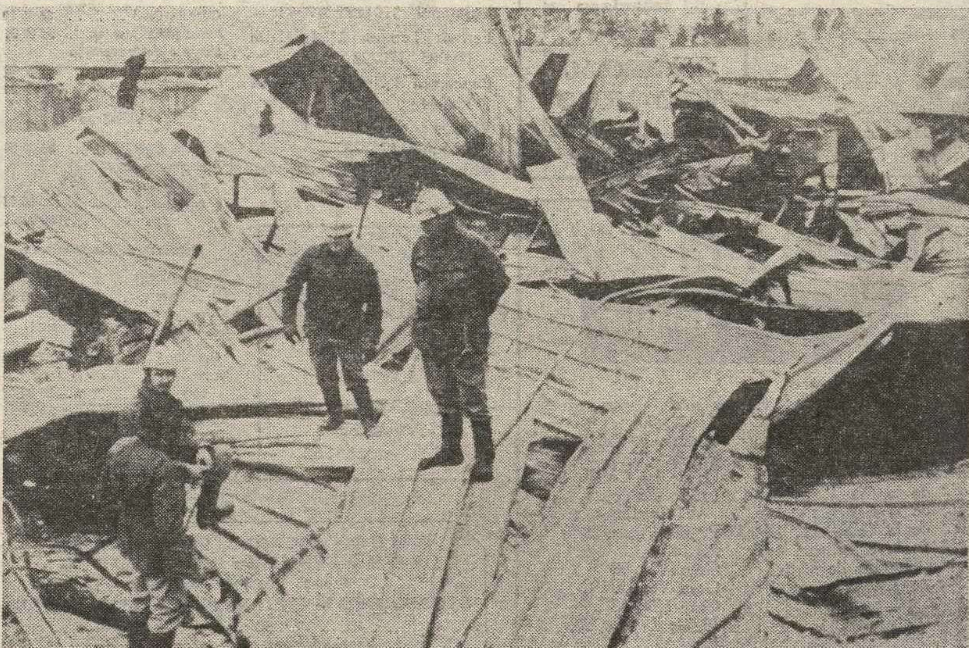
Toulouse (Francia). — Bomberos inspeccionan los daños del centro comercial Edouard Leclerc que ha quedado completamente destruido por un incendio, al parecer intencionado, por un comando de una centena de personas. (Telefoto Efe-Upi)
