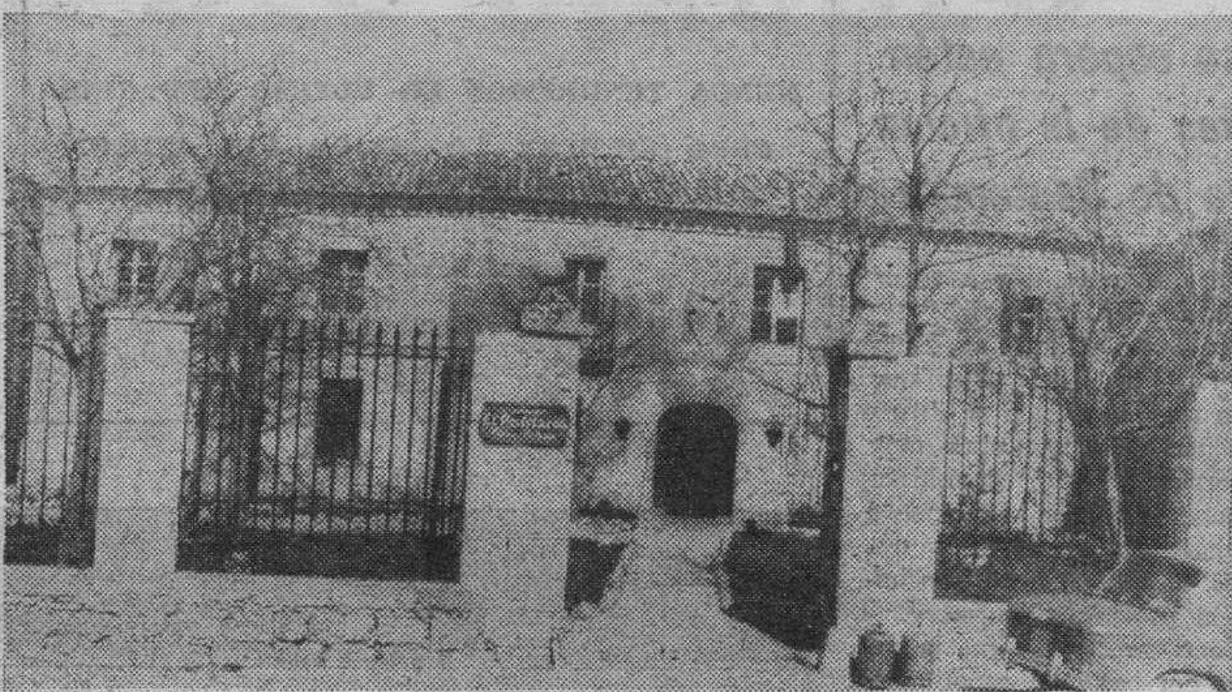
Una vista frontal de la casa palacio en que está radicada la asociación «El Patriarca» (Foto FEDE)
