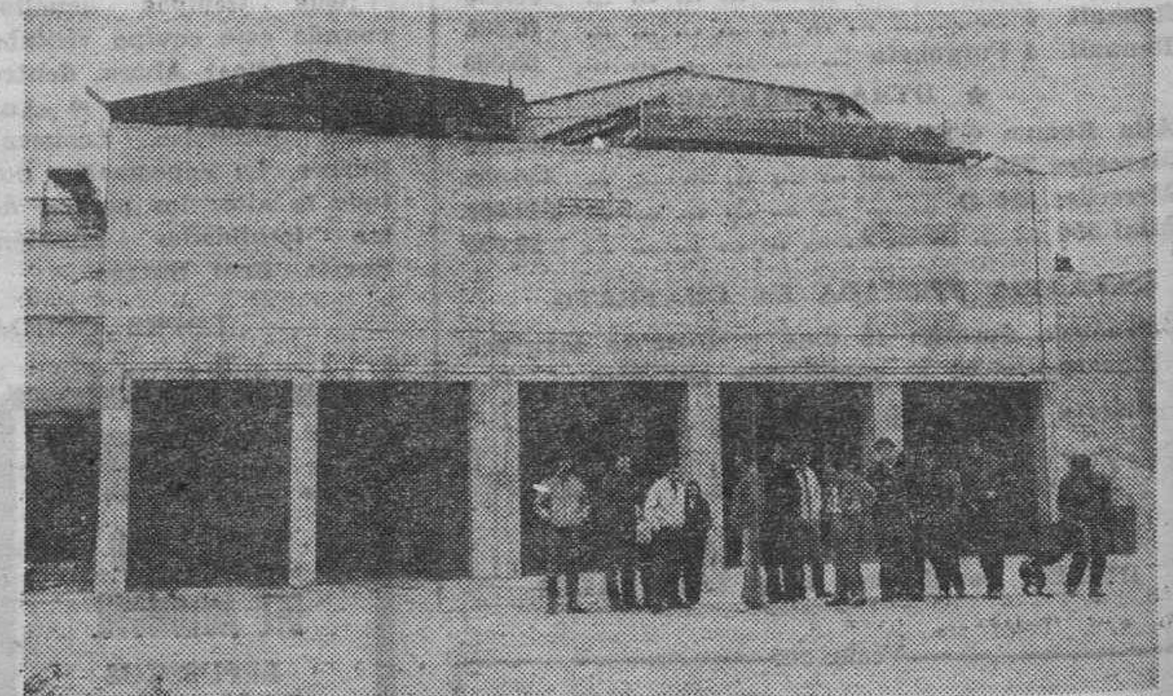
Vista parcial de las instalaciones de graveras «SAIZ» sitas en Espinosa de Juarros.
