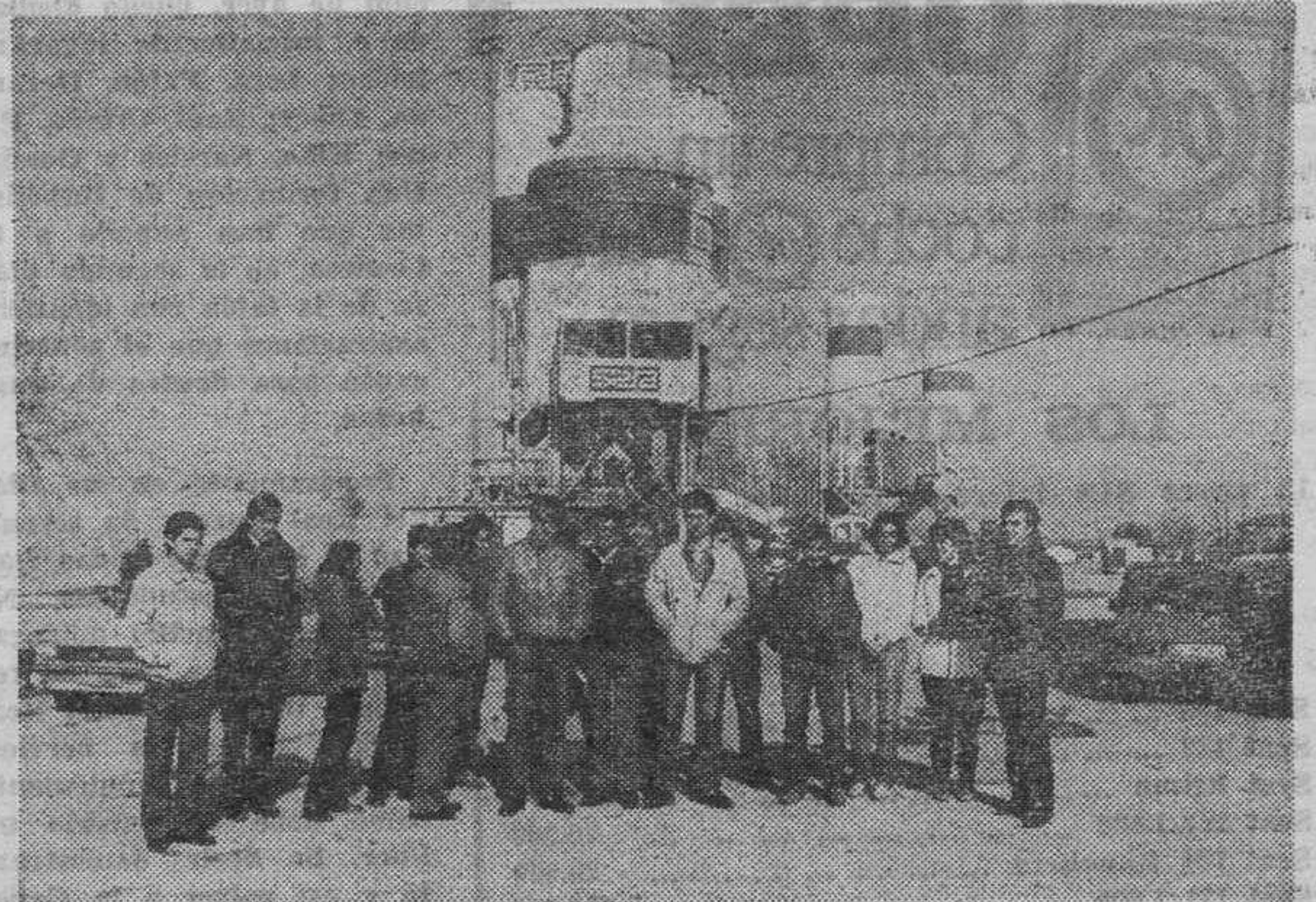
Vista parcial de las plantas de hormigones «SAIZ» sitas en el B.º de Castañares.
