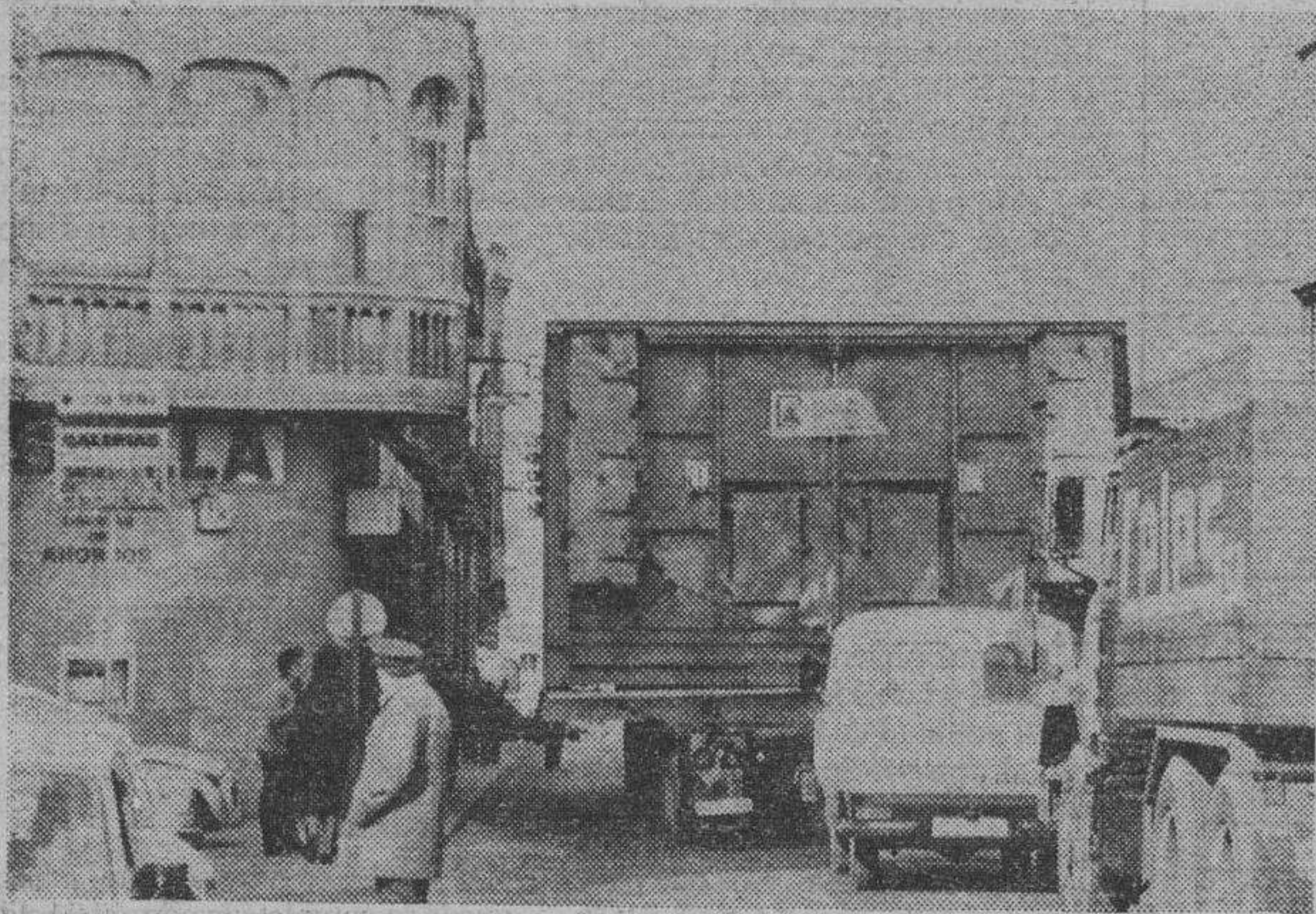
Instantánea captada por Florentino Lara, en la que un camión de gran tonelaje, juega a tapar la calle a la altura del edificio Romera en el antiguo trazado de la Nacional I.
