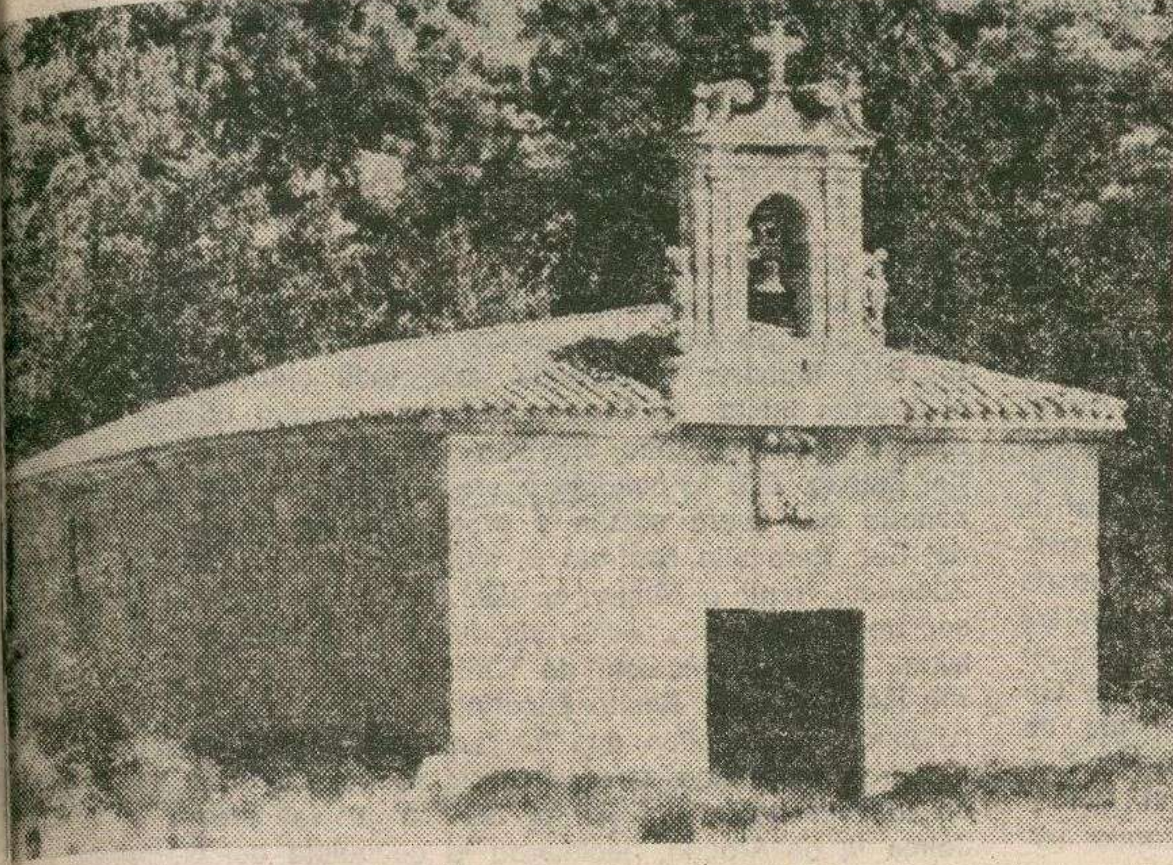
Ermita del Santo Cristo del Priorato, alejada del pueblo.
