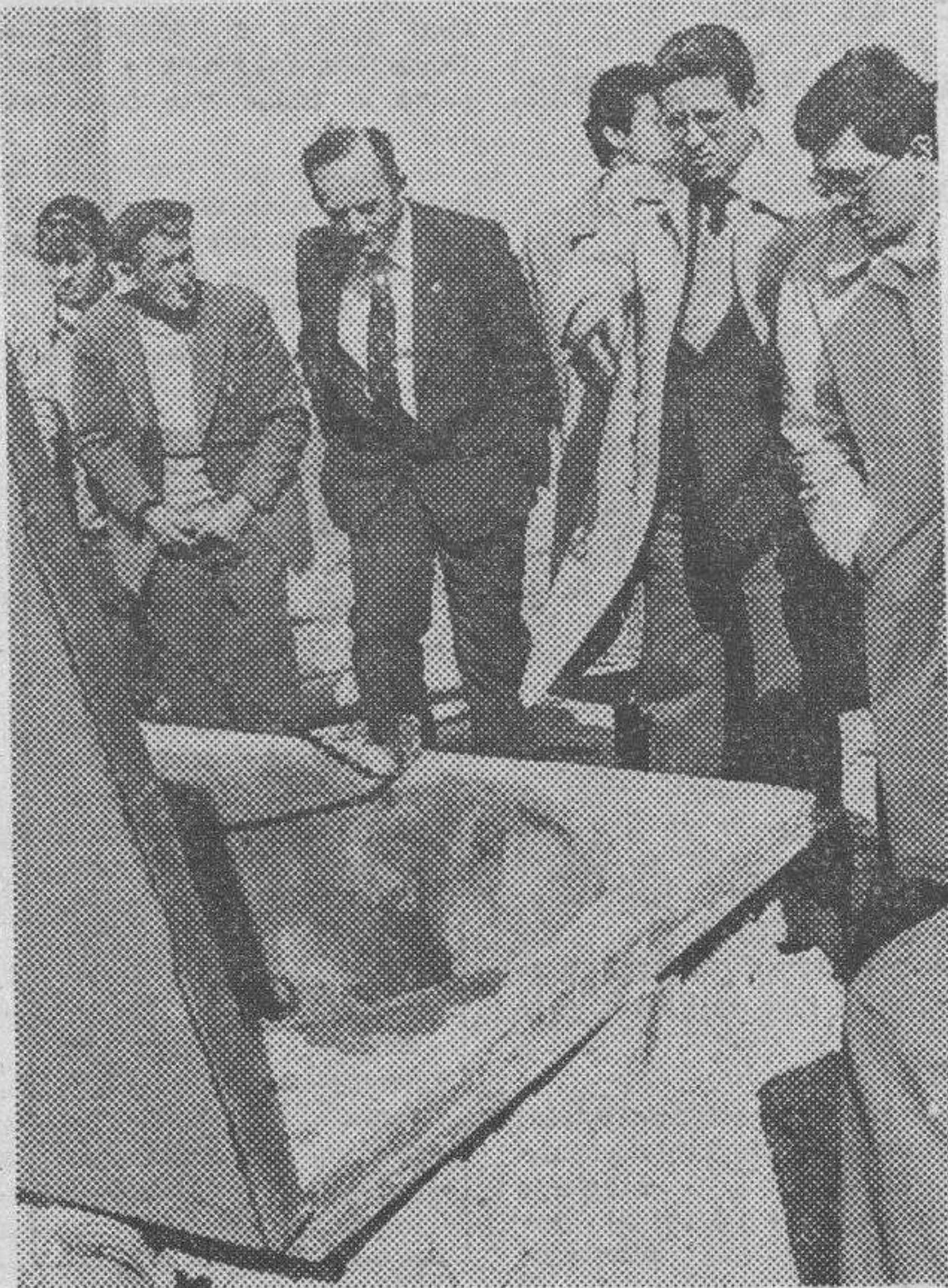
Un momento de la visita a las instalaciones del pozo de agua de Villaquirán de los Infantes, desde donde se bombea hasta el depósito que surte de agua al pueblo. (Foto Villafranca)
