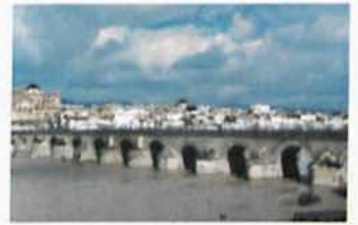
Puente romano de Córdoba.
