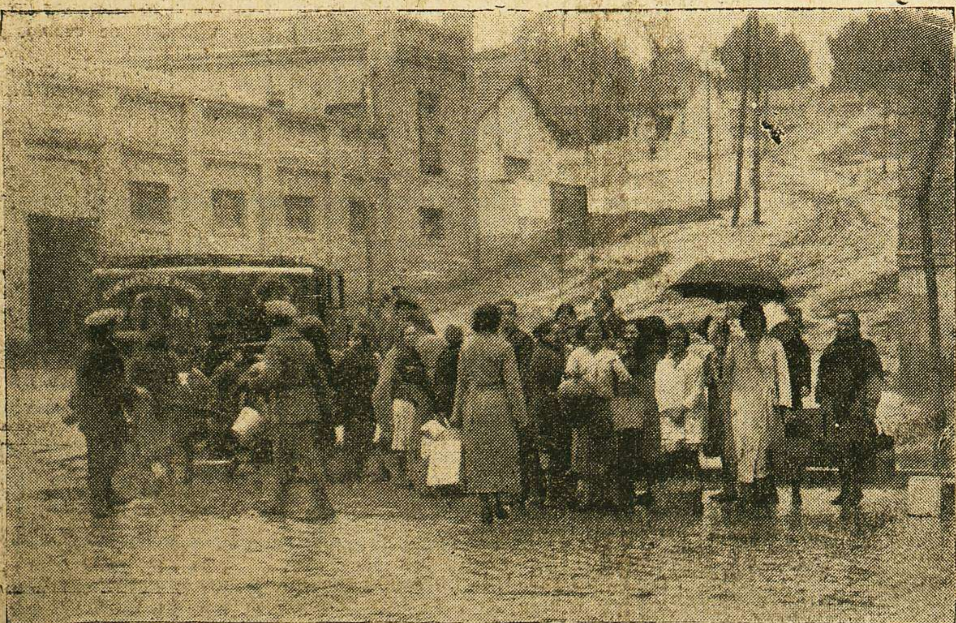
Casi medio-Madrid está sin agua, y los tanques del Ayuntamiento surten de ella a los vecinos que acuden a proveerse del indispensable líquido (Fotos-Rico).
