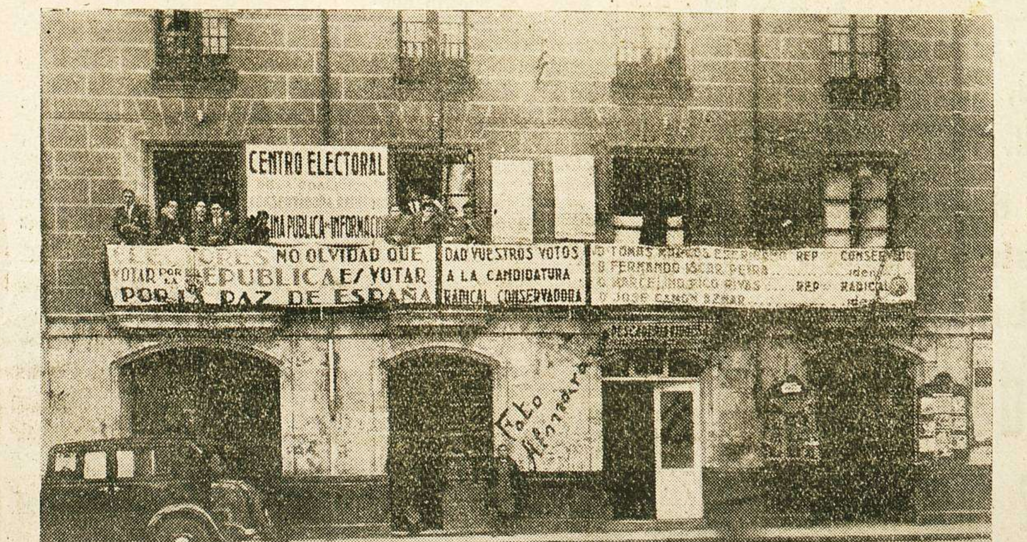
Fachada principal de la casa de la calle Dr. Riesco, 40, en donde tiene establecida su oficina de información pública y propaganda la coalición republicana Radical-Conservadora (Foto Almaraz)
