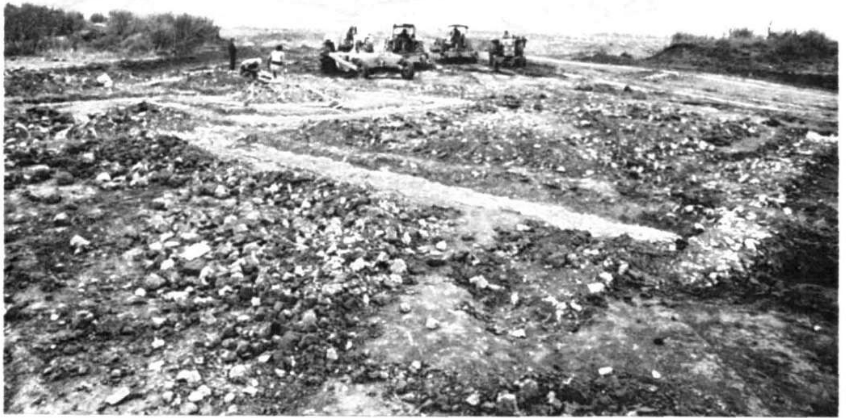
Lám. II.1. Movimientos de tierra en la zona del yacimiento.
