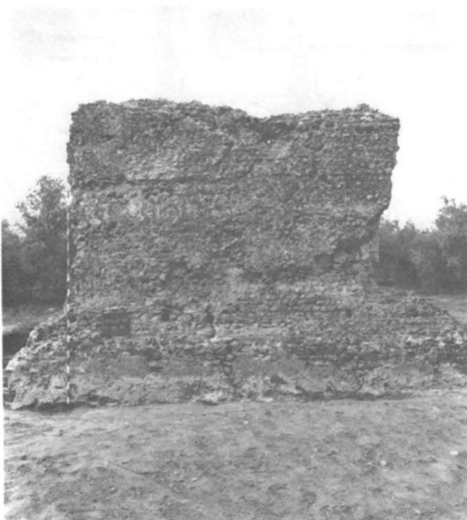
Lámina V foto 9: Vista del muro lateral derecho.
