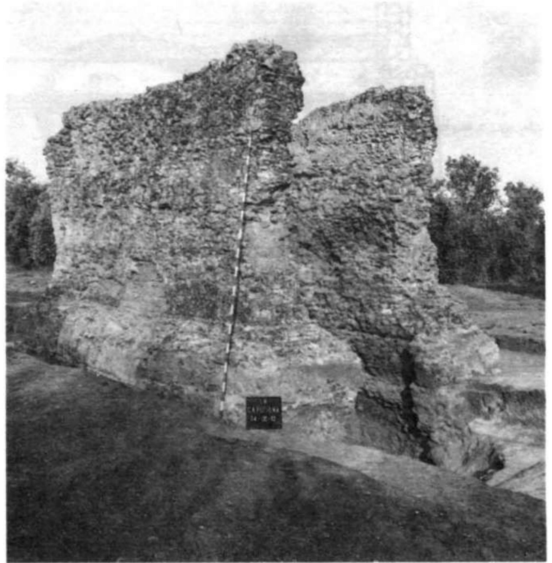
Lámina III foto 5: Detalle del muro lateral izquierdo.
