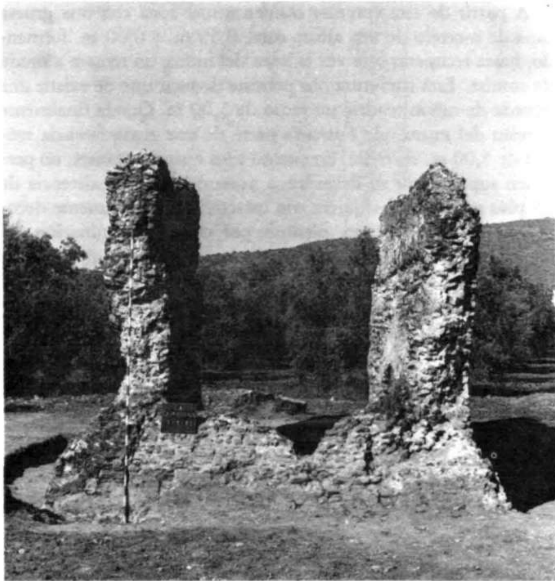
Lámina II foto 3: Vista posterior del exterior de los muros.
