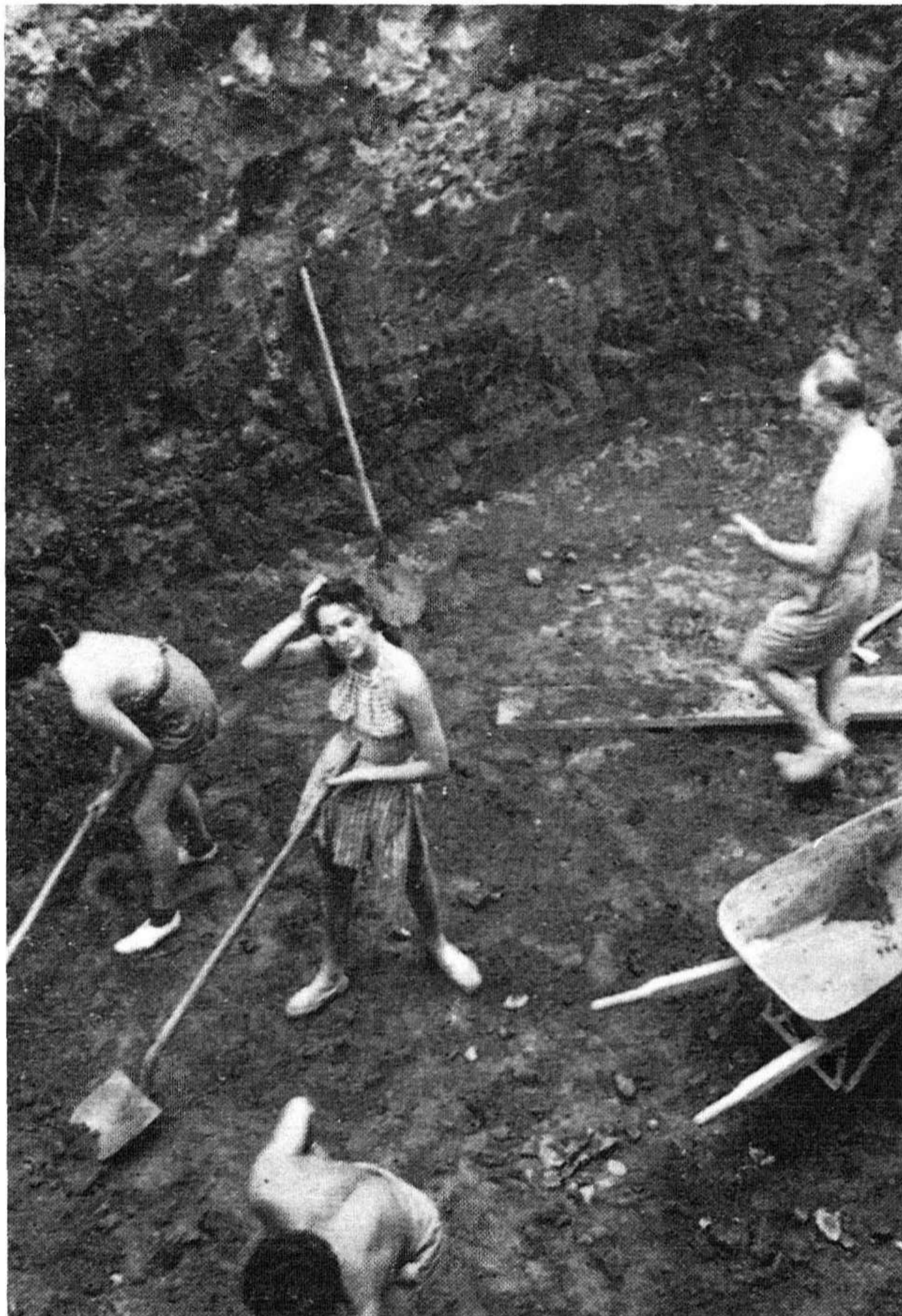
Estudiantes trabajando en la construcción del edificio.
