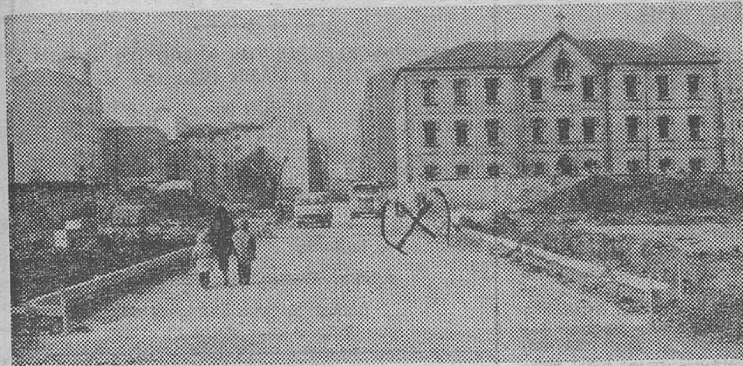
Un aspecto de la urbanización de la finca de Valderrama, donde se produjo el reventón a que se alude en esta crónica. El lugar queda señalado con una (X). — (Foto MURO)
